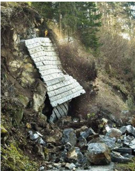
Als die Sprengmatten gelöst werden, krachen auch die übrigen losen Steinblöcke, Holzreste und jede Menge Erdmaterial auf die Glootenstrasse oberhalb der A8 bei Iseltwald. (Bild: Markus Hubacher)
