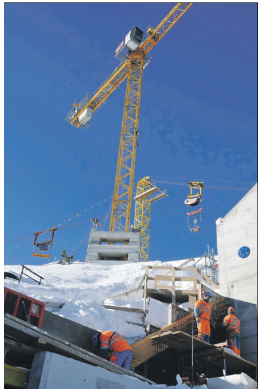
Die beiden Transportbahnen: links Richtung Sulzmattli, rechts Richtung Kälti. In der Mitte der grosse Kran.
