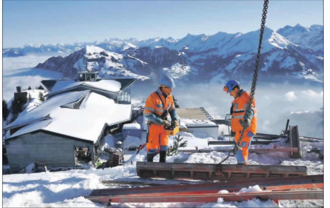
Bereits sind die Rollen für das Zugseil in der neuen Bergstation montiert (Bild links). Auf dem Bild rechts bedient Bruno Ming (links im Bild) mit dem Steuergerät den grossen Kran. Bilder Robert Hess
