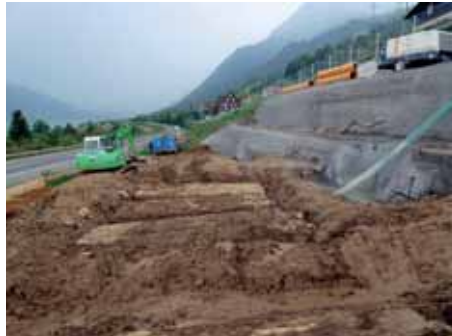
Der Einsatz von Baggermatratzen war unerlässlich.
