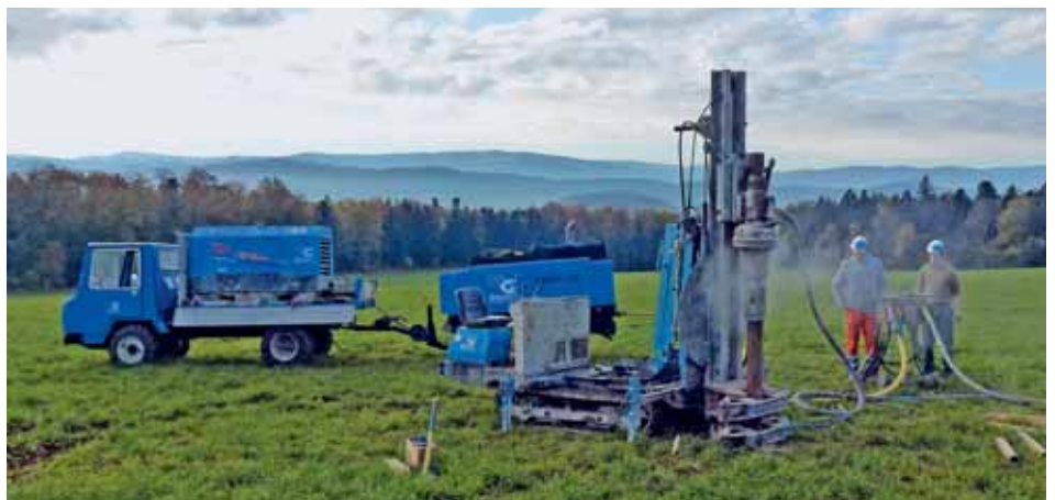
Eine nicht alltägliche Baustelle.
