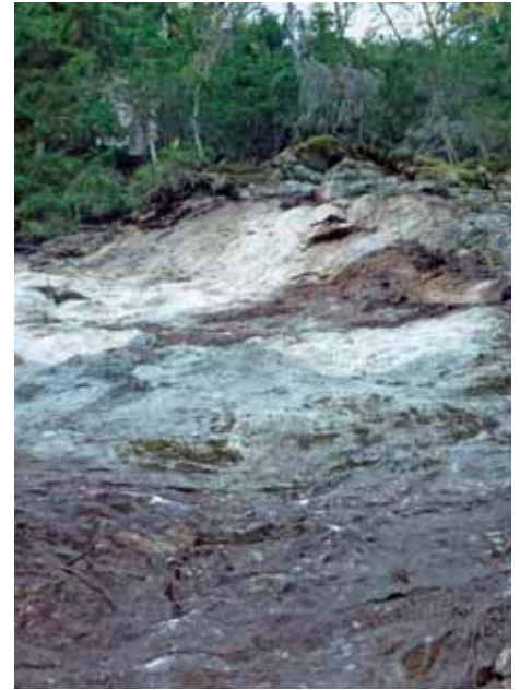
Die saubere Felswand nach der Sprengung.
