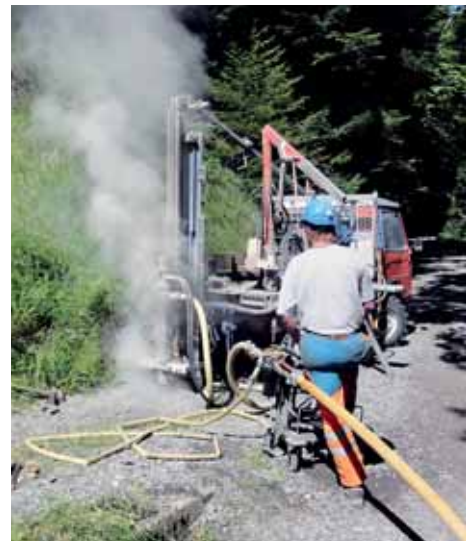
Bohrarbeiten im kleinen Melchtal.
