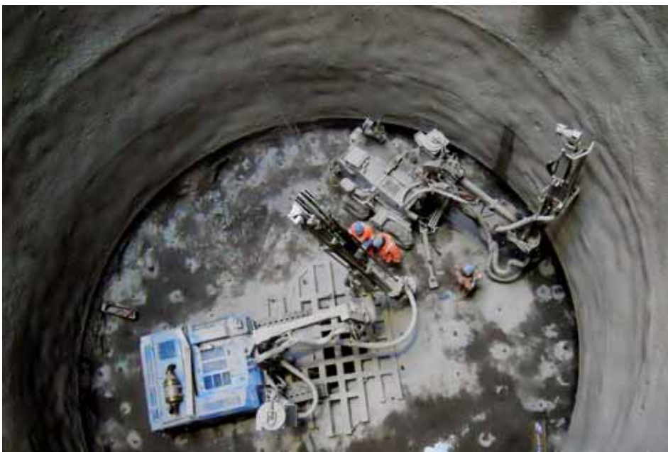
Bohren eines Abschlags.
