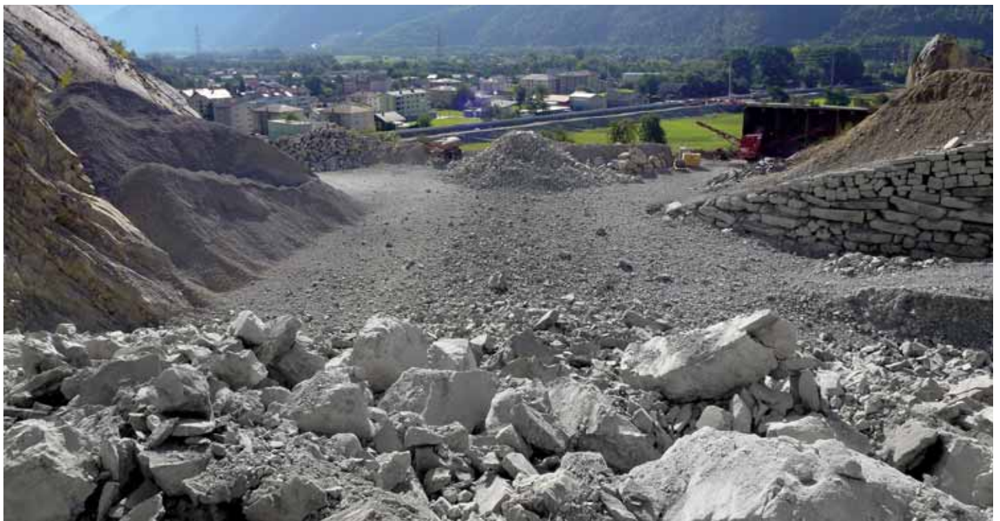
Bei der kontrollierten Auslösung der Sprengung ereignete sich aus der Bruchwand ein Schleuderwurf.
