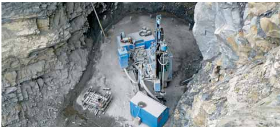
Bohrarbeiten in der Runse.
