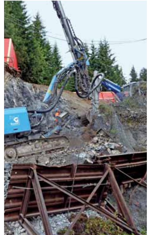
Felsabbau beim Schräglift mit den Sicherungsmassnahmen.
