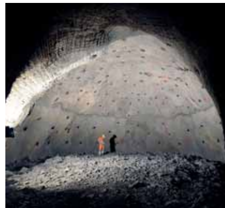
Gewölbe der Schwallkammer.
