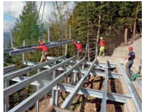
Montage Stahlkonstruktion durch die Sutter AG.
