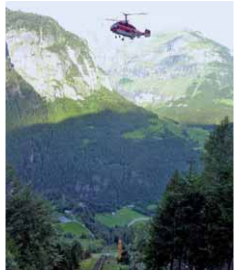
Montage Kran Drosselklappenkammer.
