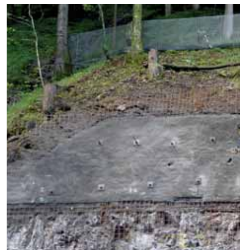
Temporäre Sicherung mit Montage des Hochleistungsnetzes oberhalb des Hanges.
