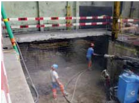
Gasser-Mitarbeiter bei den Spritzbetonarbeiten.
