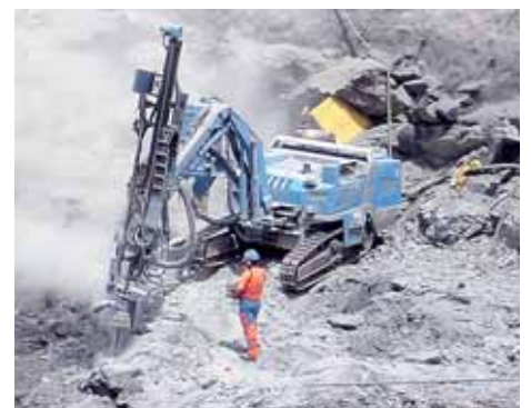
Bohrarbeiten für Felsabtrag.
