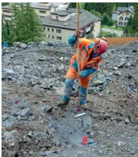
Ladearbeiten der Sprenglöcher.
