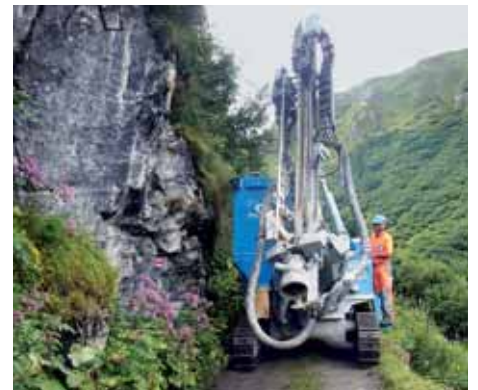
Bohrgerät Techmo auf schmalem Alpweg.
