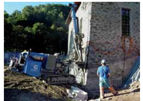
Bohren der Mikropfahle.
