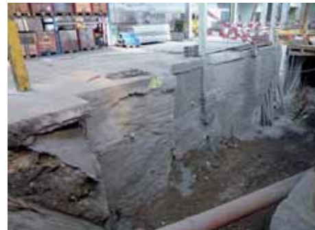
Gesicherte Mauer in einer Halle der von Roll AG.
