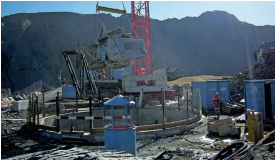
Transport des Bohrgeräts in den Schacht.
