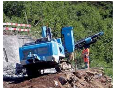
Bohrarbeiten für Anker.
