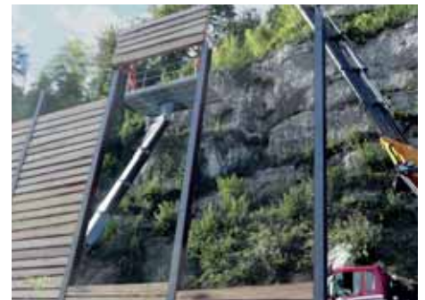
Einbau Bohlenwand.
