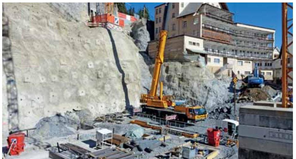
Fertig erstellte Baugrube Scarlett.
