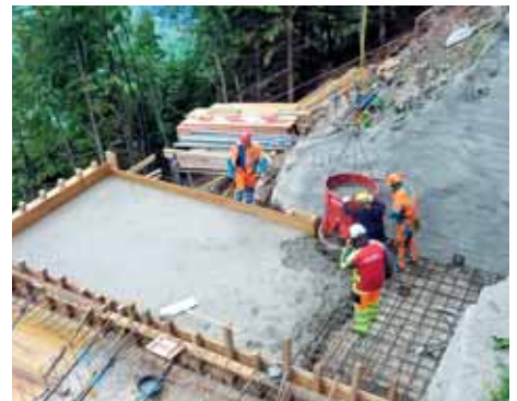
Betonieren Bodenplatte Bergstation.
