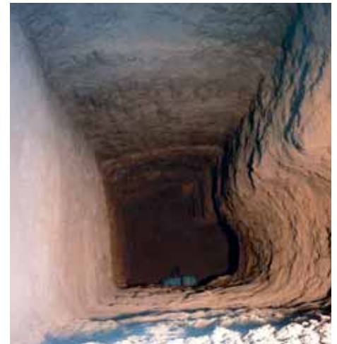
Der fertig ausgebrochene Liftschacht.
