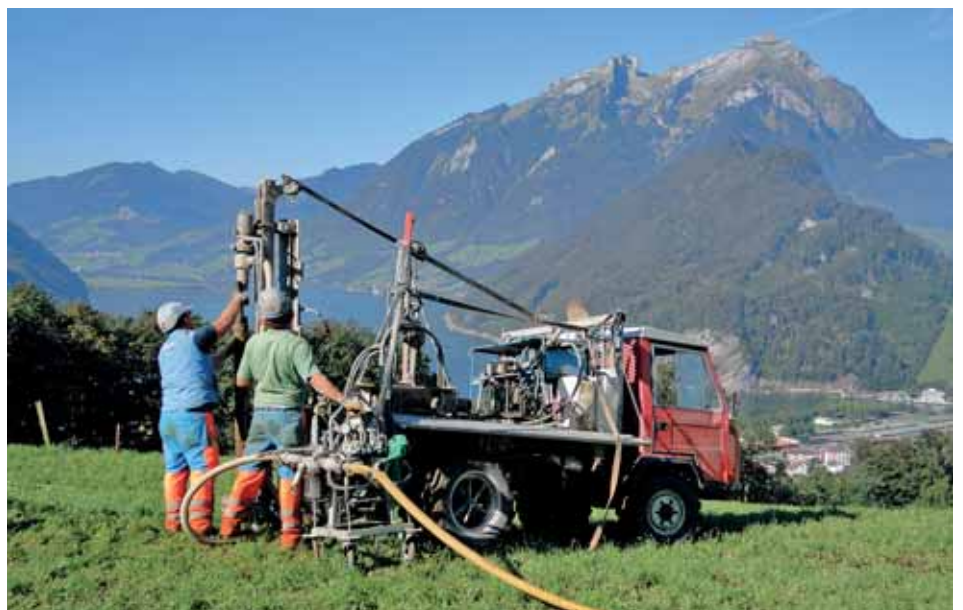
Mounity-Bohrgerät auf Muli-Geländetraktor auf dem Bürgenstock.
