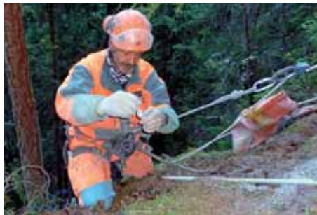
Laden der Sprenglöcher.
