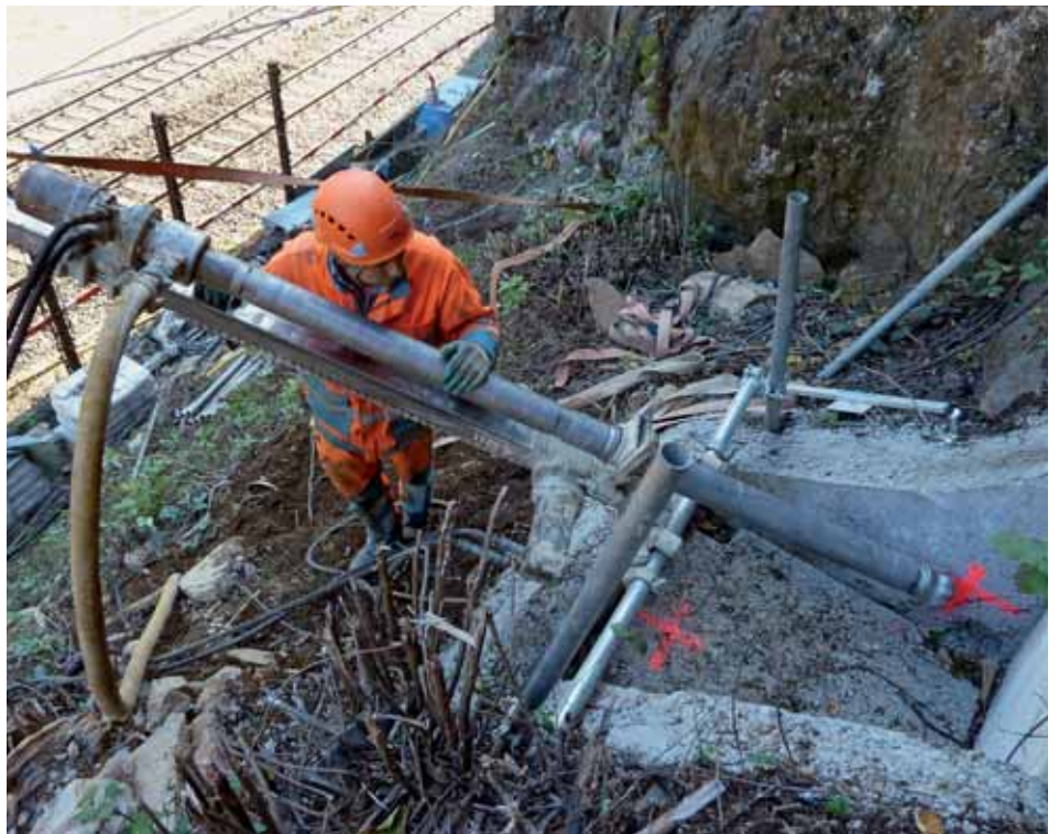
Bohrung der Fundamentanker mit der Leichtbohrlafette.
