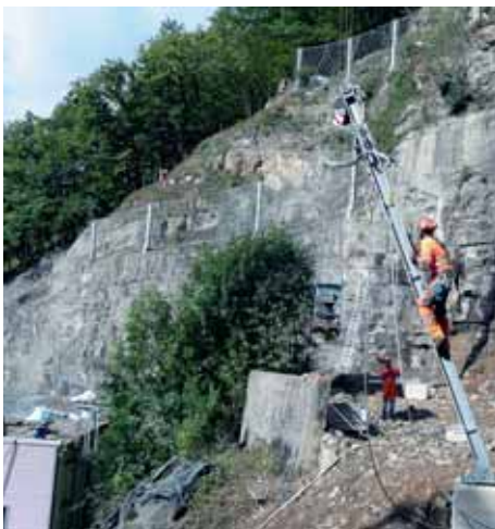
Montage Steinschlagverbauung 2000 kJ.
