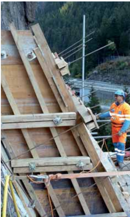
Schalung Betonpfeiler Baustelle Getzlingen.
