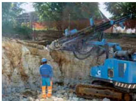
Bei den Bohrarbeiten.
