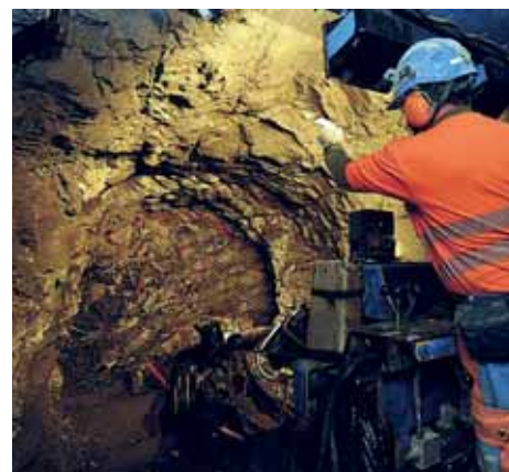
Letzte Bohrarbeiten für den Durchschlag.
