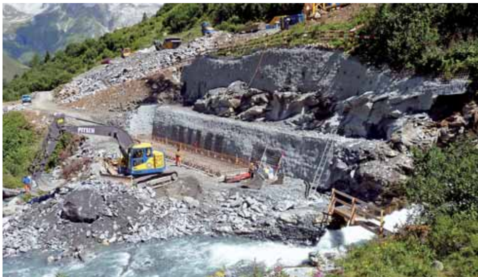
Die fertige Baugrube der Wasserfassung.
