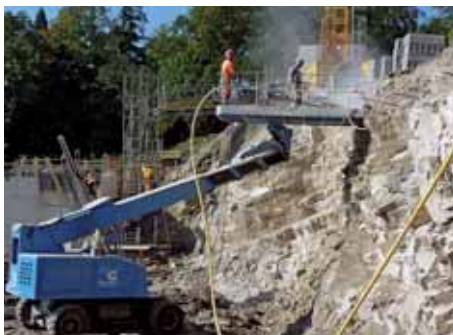
Bohrarbeiten von der Hebebühne.
