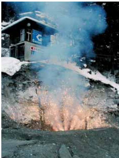
Anschliessen am 15. Januar bei eisiger Kälte.
