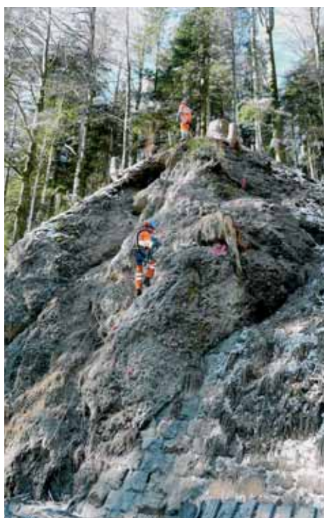
Gereinigte Felsschwarte vor der Sprengung.
