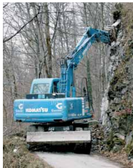
Felsabtrag unter engen Platzverhältnissen.
