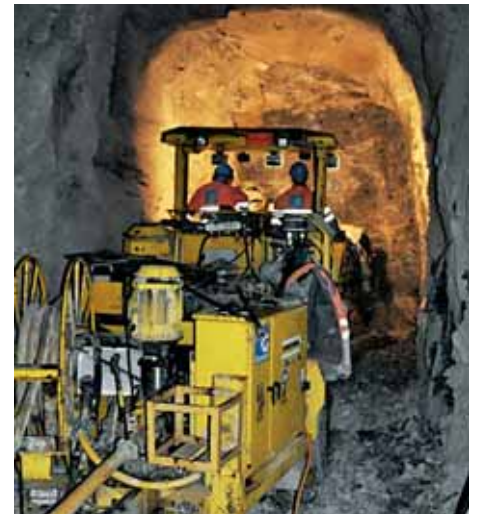
Sprengvortrieb Schrägstollen.
