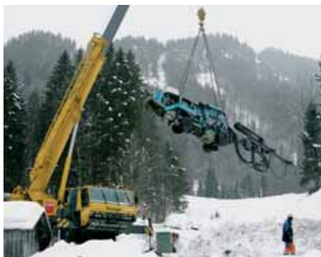
Bohrwagen wird aus dem Staubecken gehoben.
