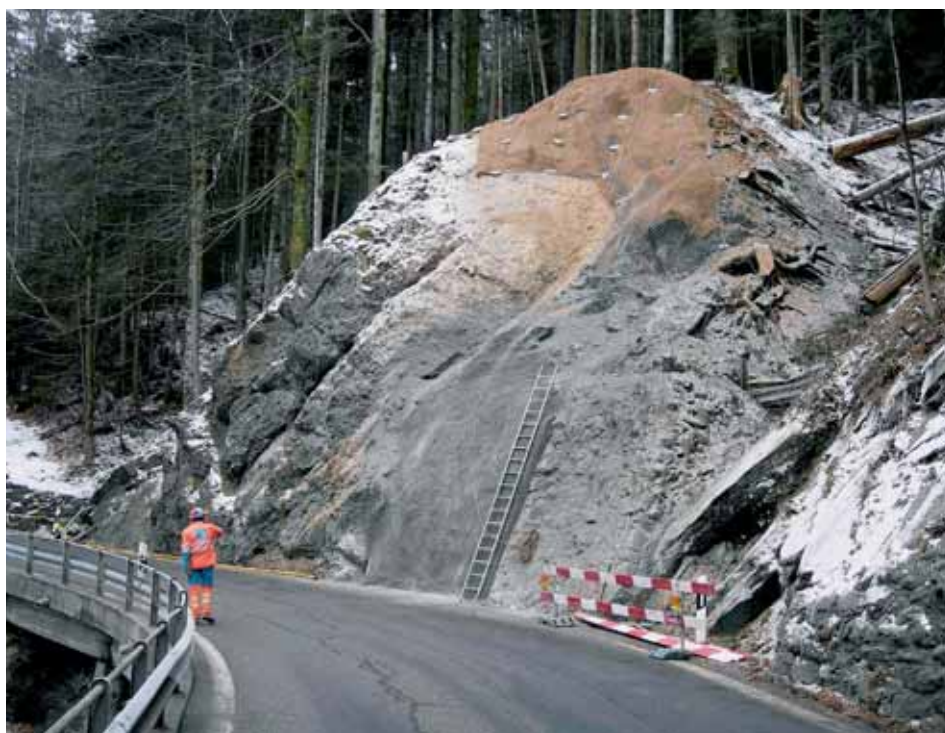
Gesicherte Böschung nach Bauende.
