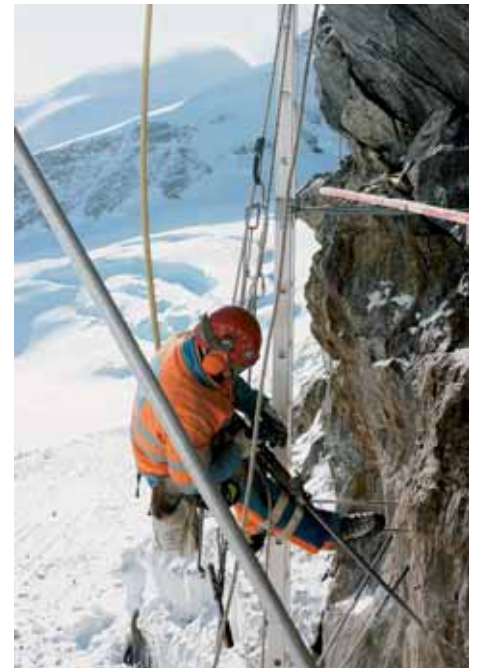
Für das Gerüst werden Verankerungen gebohrt.
