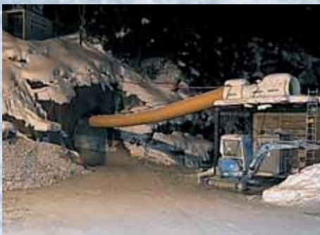
➤ Portal Schrägstollen in Grindelwald.
