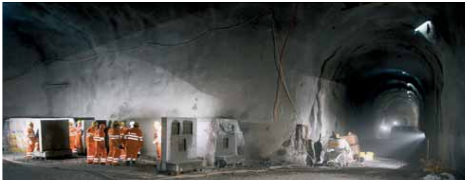
Spritzversuche im TechnoTunnel
