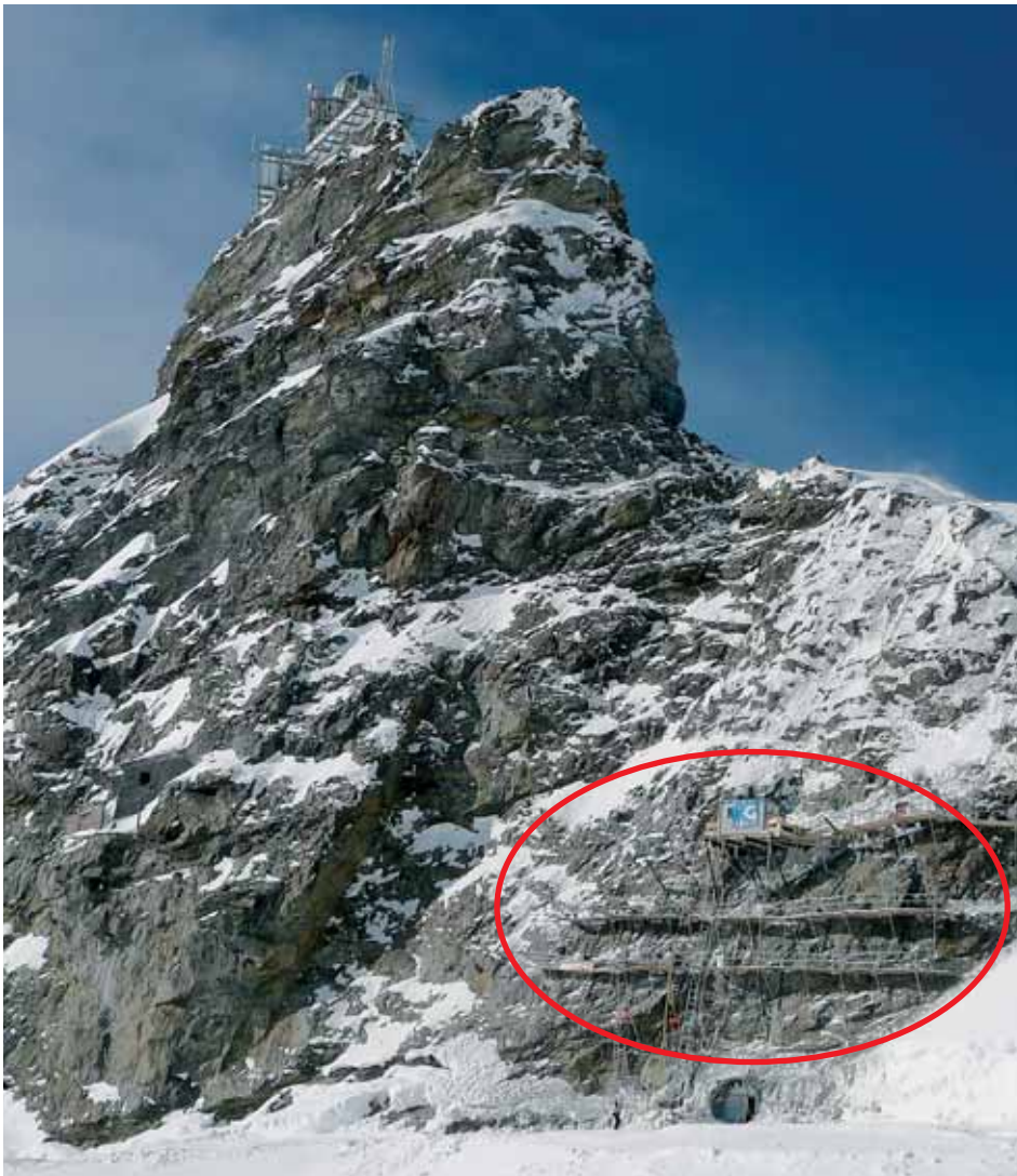
Baustelle unterhalb der Sphinx.
