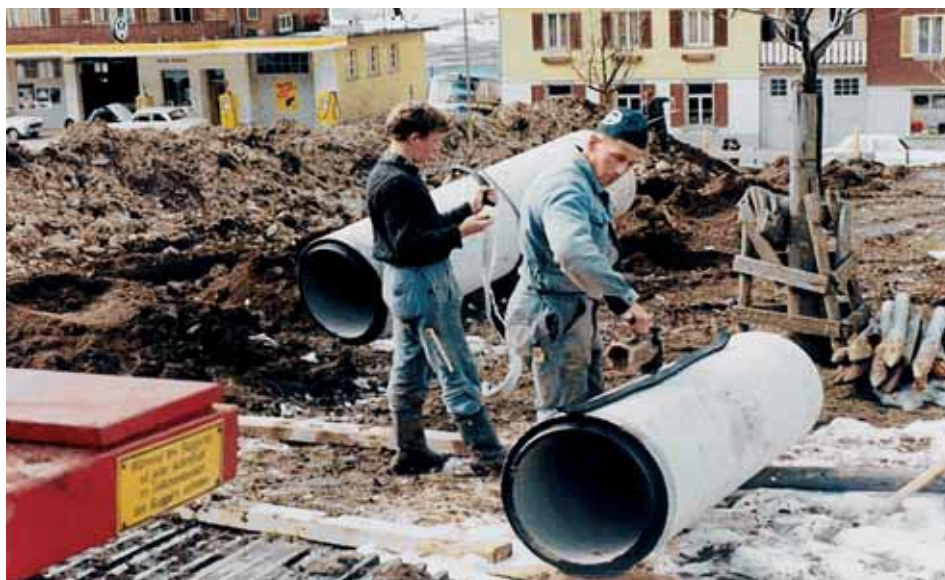
«Ohrenringler» Hans mit Maurerstift «Schali» beim Bau der Kanalisation Eimatte im Jahre 1969.
