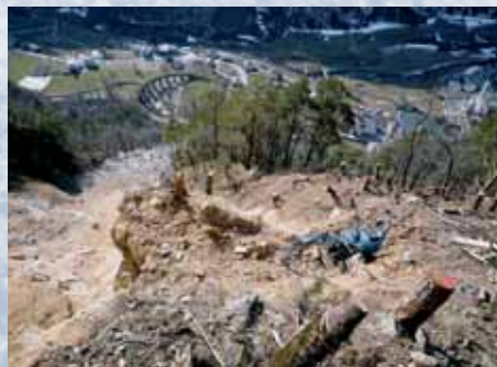
➤ Felssturz beim Viadukt in Brusio.
