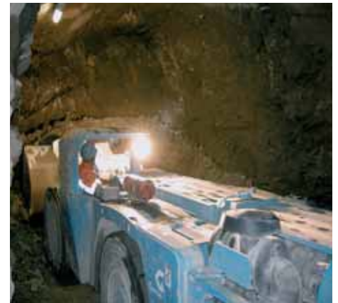
Materialschutterung mit Lader Toro 006.
