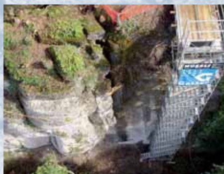
► Spalten und Gerüstturm, Horloui Weggis
