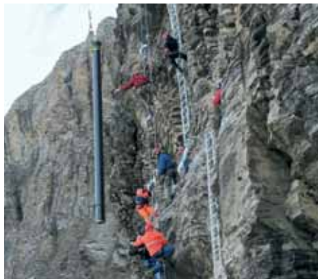
Rohrleitungsbau in der Vertikale.
