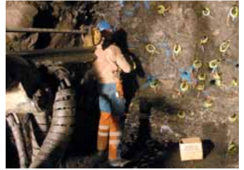
Laden der Bohrlöcher vor dem letzten Abschlag
