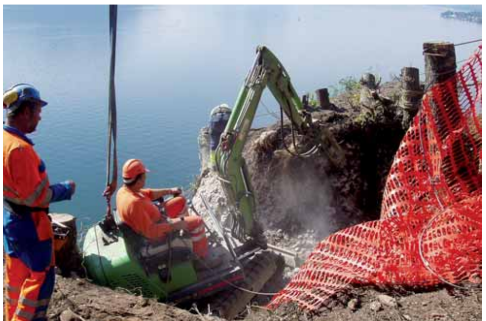
Kontrollierter Felsabbau in luftiger Höhe.
