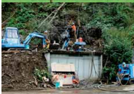
Unverrohrte Zielbohrung: Länge 75 m, Durchmesser 20,3 cm, Steigung 48° in Giswil.
