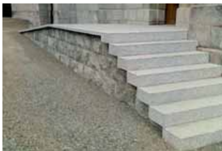
Neuer rollstuhlgängiger Zugang zur Kirche.
