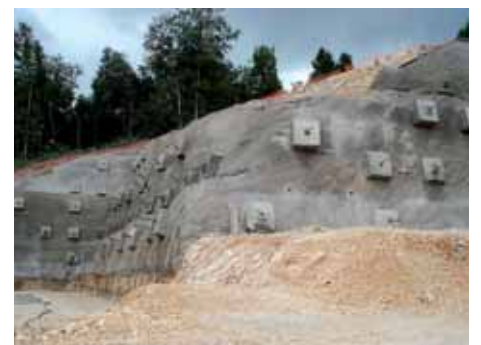
Spreng- und Ankerarbeiten im Voreinschnitt des Tunnels du Bois.
