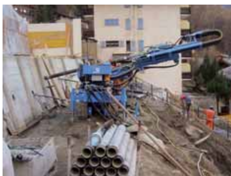
Verrohrtes Bohren für Baugrubensicherung.
