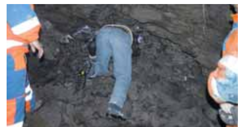
Bauherr Marcel Bach schlüpft als erster durchs Loch.
