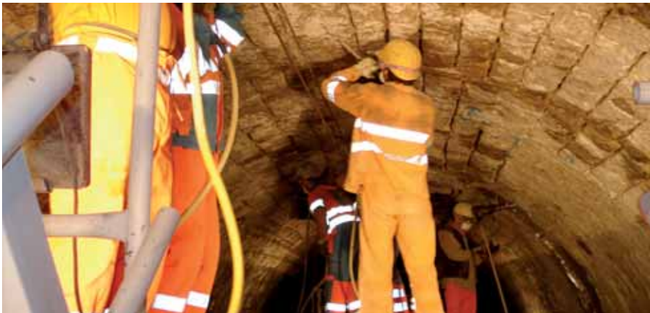
Sanierung der Mauerwerke in den Tunnels les Crosettes und la Combe-Creux.
