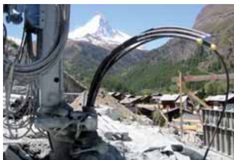
Neues Spezialbohrgerät für Erdwärmesonden-Bohrungen...
