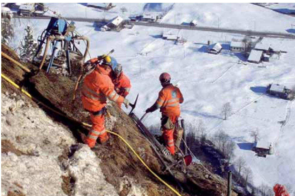
Exponierte Bohrarbeiten hoch über dem Kandertal.
