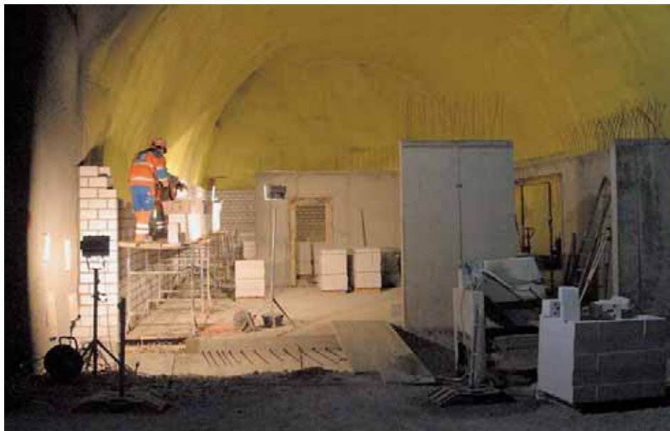
Hier entsteht das Herz des Brandschutzstollens, die Technikzentrale.
