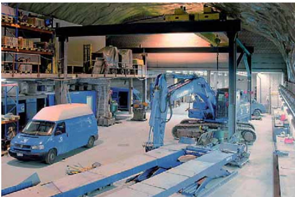
Provisorische Werkstatt während der Bauzeit.
