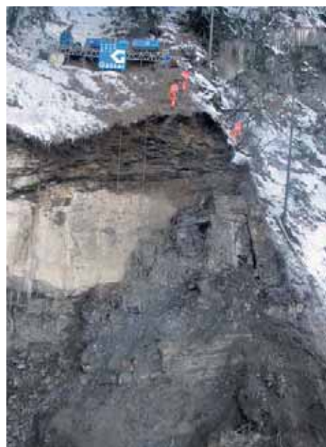
Bauinstallation oberhalb der Abrisskante.
