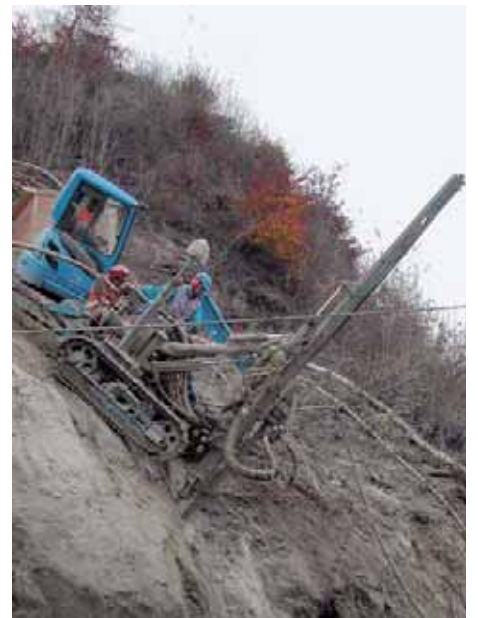
Bohrarbeiten in steilem Gelände.
