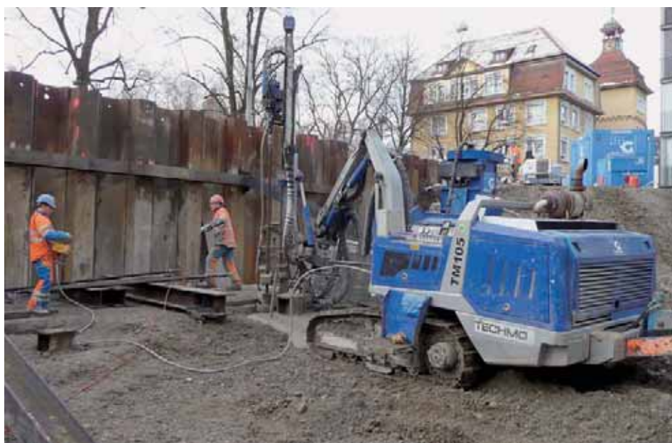
Setzen von Mikropfählen im Dickpülverfahren.
