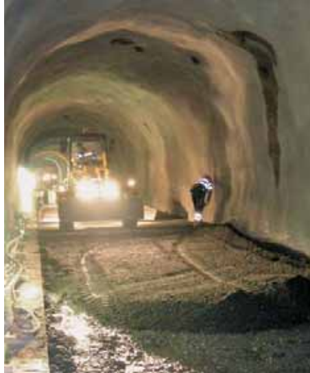
Einbau der Fahrbahn.
