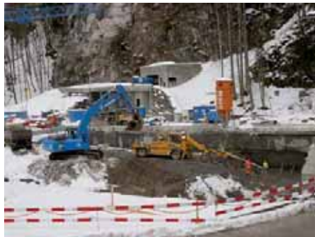
Grossbaustelle für die neue Werkstatt.
