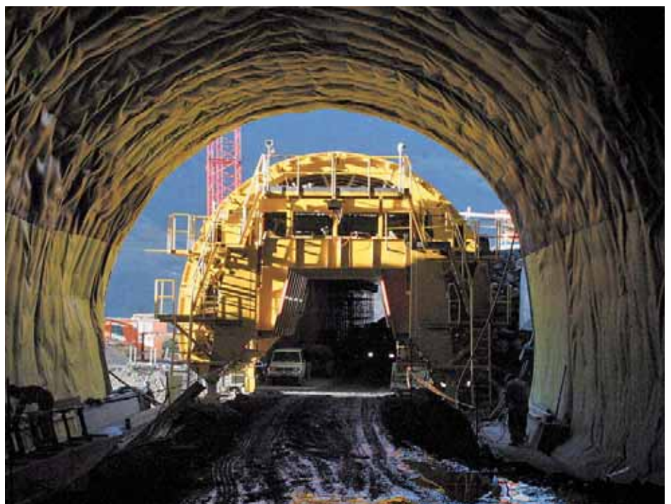
Gewölbbeschalung vor Einbau im Nordportal.
