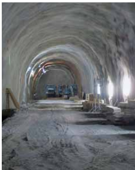
Brandschutzstunnel bereit zum Innenausbau.
