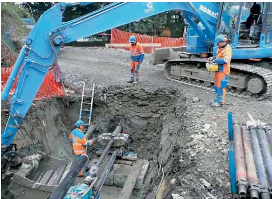
Zielbohrung 18m lang für Wasser- und Abwasserleitung.
