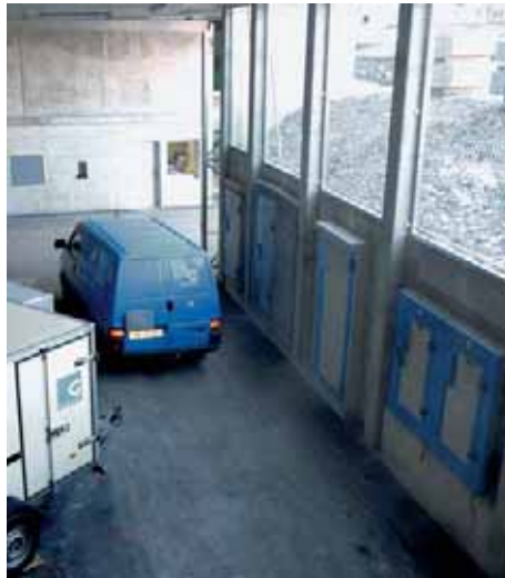
Neue, wettergeschützte Magazine im Vorraum des Sprengmittellagers.
