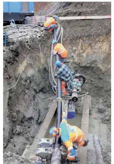
Einziehen der Rohrleitung, Ø 219mm.
