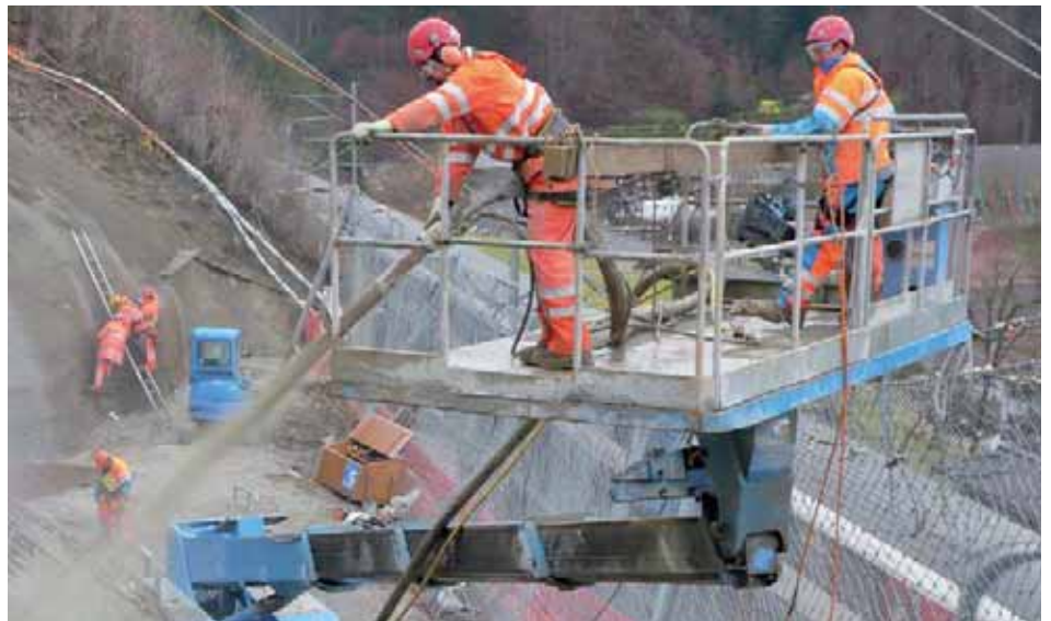
Spritzbeton, 10m über Terrain.
