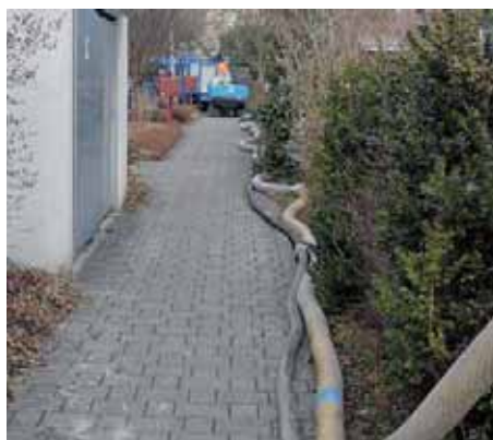
Förderstrecke für Bohrschlamm, über 60m lang.
