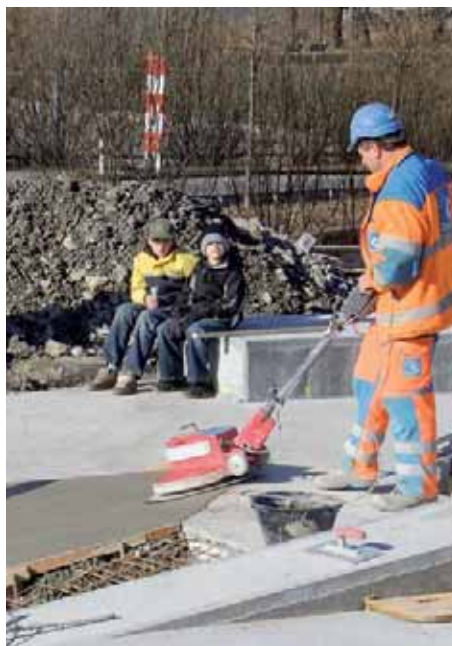
Zaungäste beim Inspizieren der Bauarbeiten.
