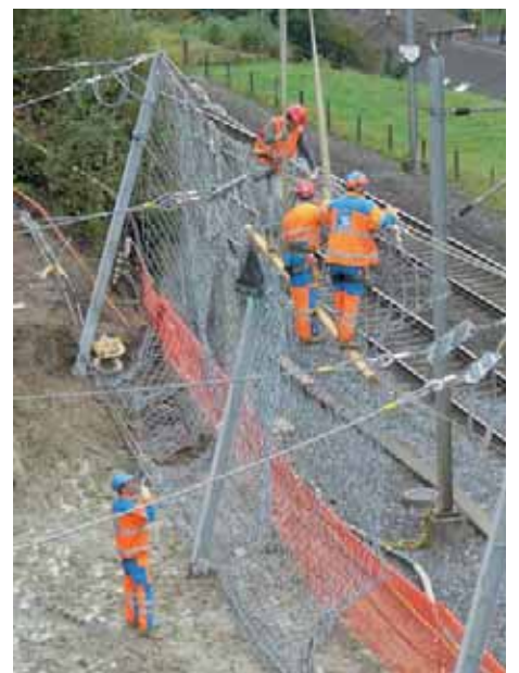
Provisorischer Steinschlagschutz 2000 kJ.
