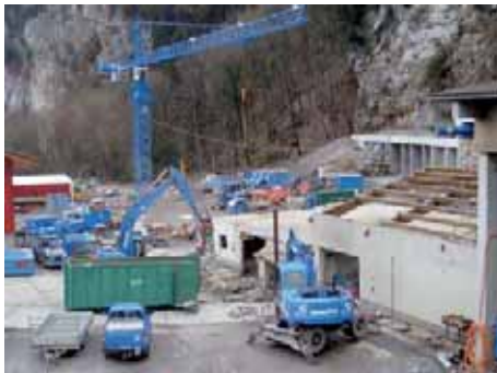
Abbruch der alten Werkstatt.
