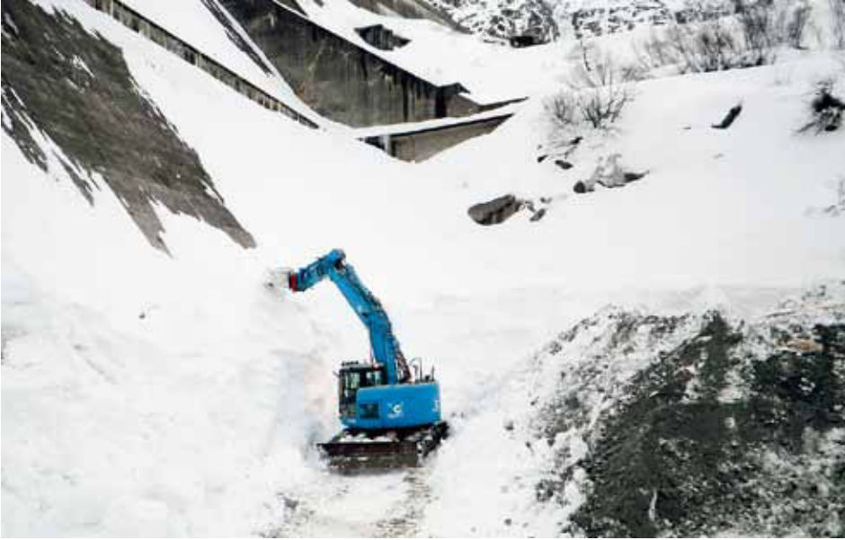
Schneeräumung Deponie Gerstenegg Mauer.
