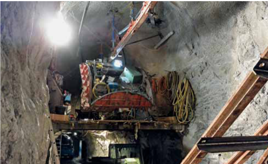
Alimakbühne im Schachtfuss während Geleisemontage.
