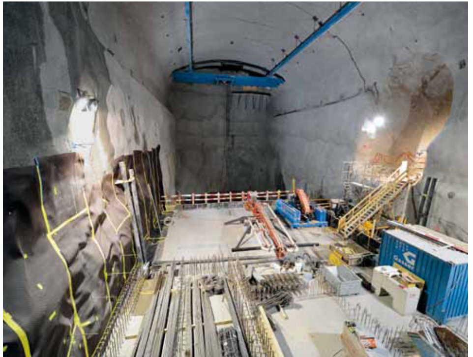
Innenausbau Maschinenkaverne HAZE.
