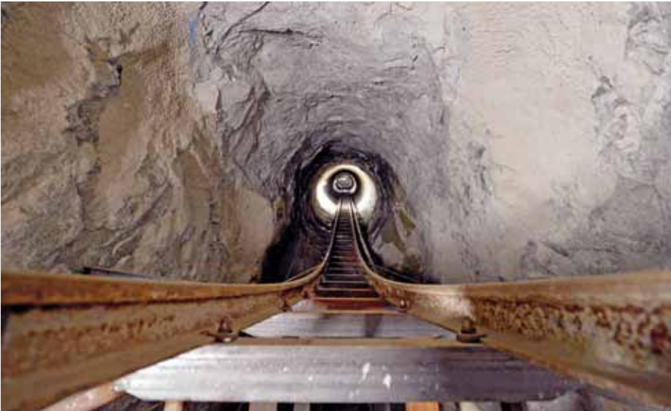
Schiene zum Verlegen der Stahlpanzerung im Schrägschacht.
