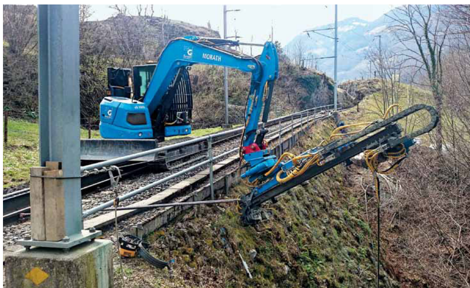
Bohrarbeiten für Wanderwegsteg.
