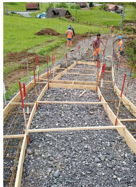
Betonieren der Fahrspur.
