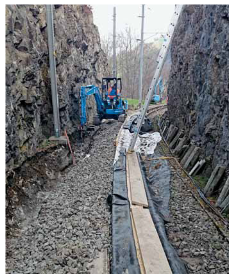
Grabarbeiten entlang der Geleise.
