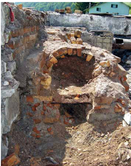
Abbruch Pferdestall in Luchsingen (GL).
