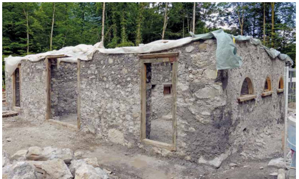
Die Grundmauern sind aufgerichtet.
