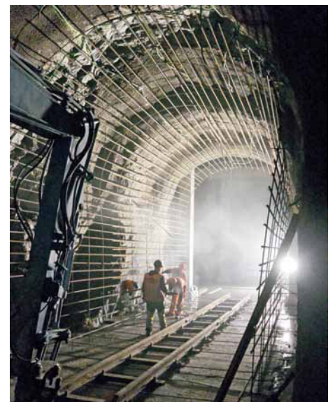
Vorbereitung für Anschlusspanzerung.
