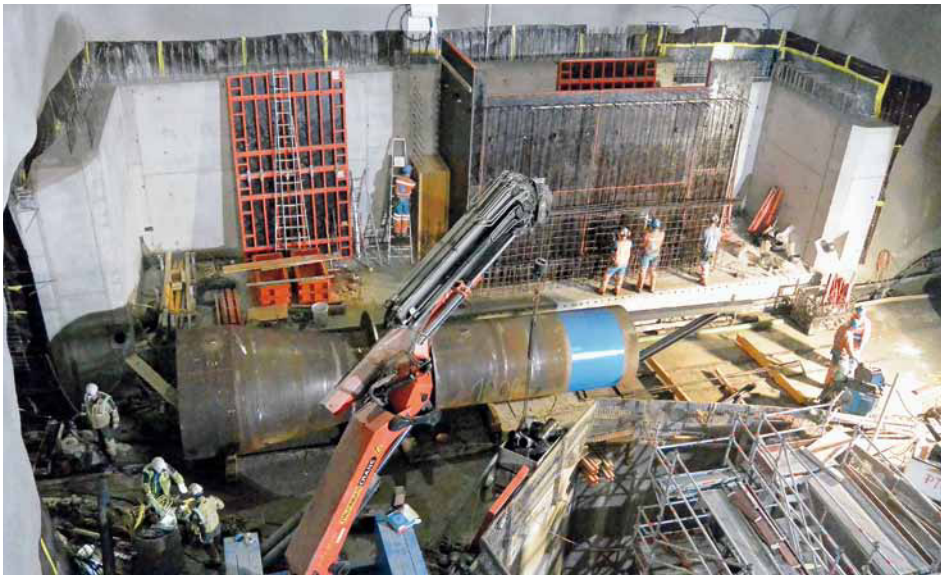
Bereich Maschinenblock mit gelagertem Panzerungsrohr.
