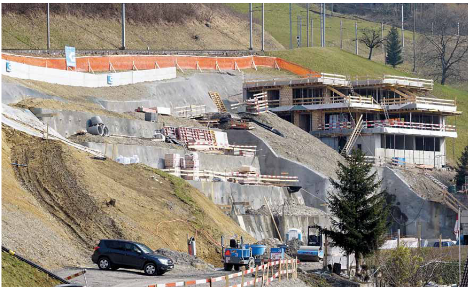
Baugruben und Neubau Überbauung Hübeli.
