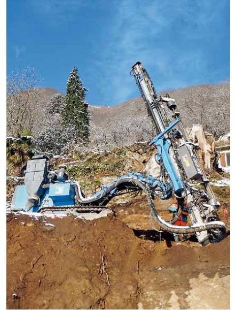
Sprenglöcher bohren.
