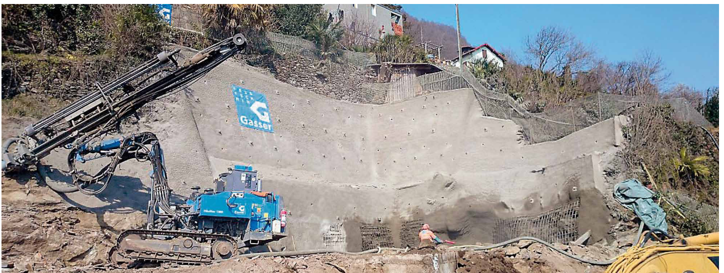
Spritzbetonarbeiten Voreinschnitt Liftschacht.
