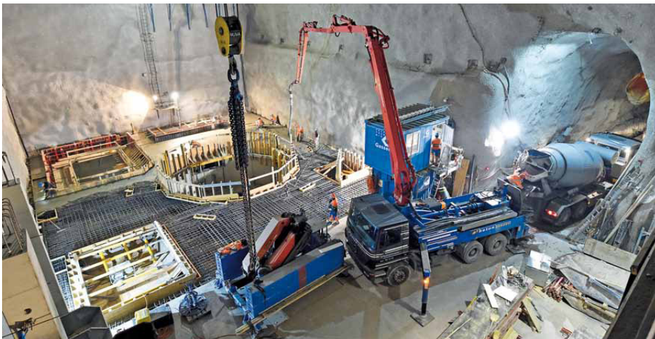
Einbringen Beton für Maschinensaaldecke.
