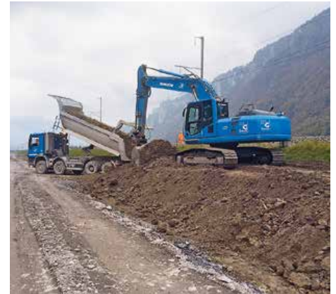
Einbau Schüttmaterial
