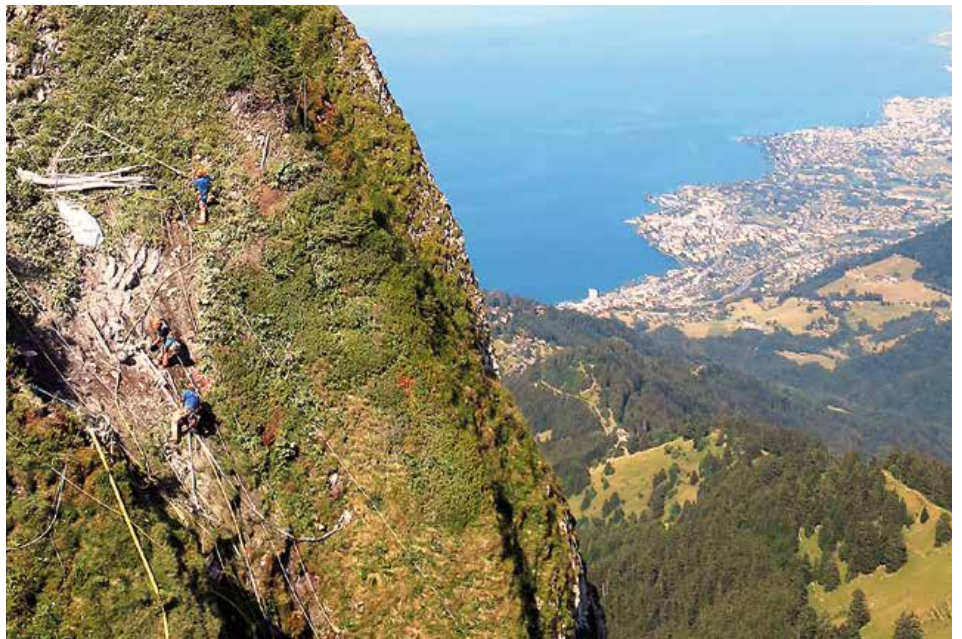
Bohrarbeiten in der Lawinenrunse
