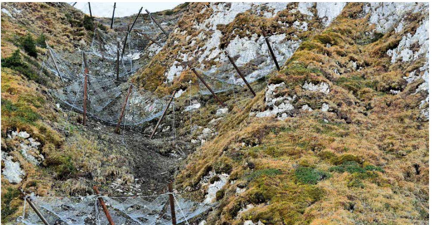
Neu erstellte Lawinerverbauungen
