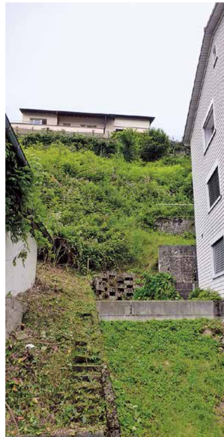
Böschung vor Beginn der Baugrubensicherung
