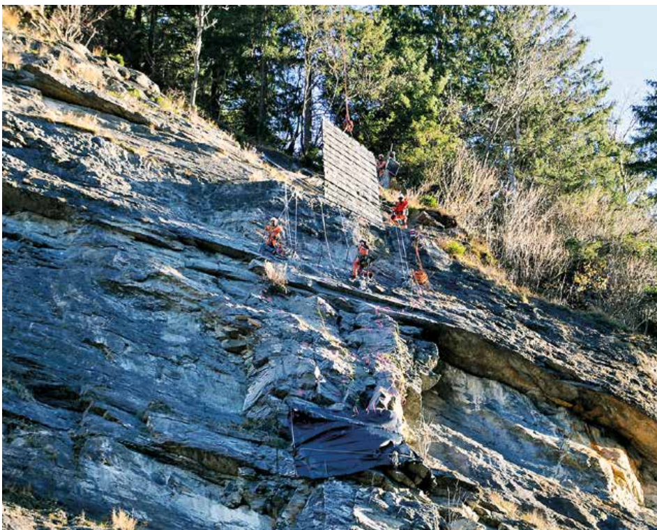
Die labile Felspartie wird mit Sprengschutzmatten abgedeckt
