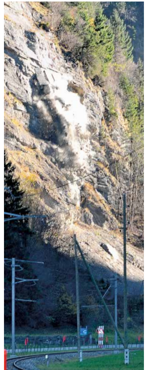
Die Sprengung ist geglückt
