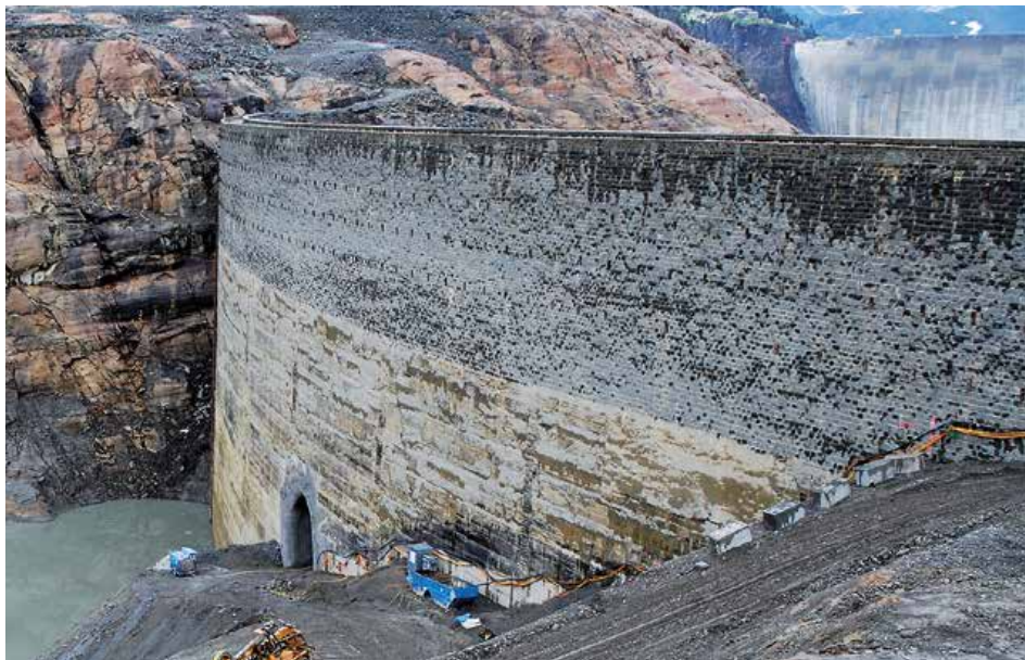
Im Vordergrund die alte Staumauer Barberine, im Hintergrund die neue Staumauer Emosson
