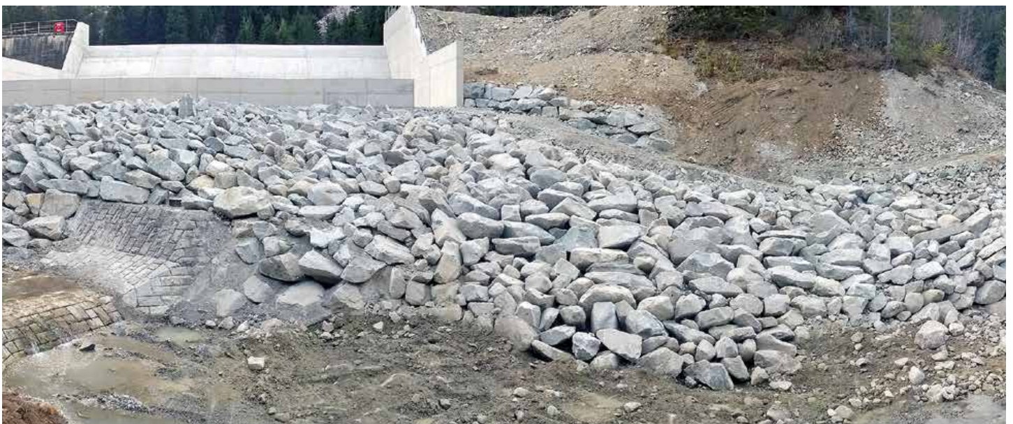
Steinsatz im Bereich Auslaufbauwerk Handeck (5)
