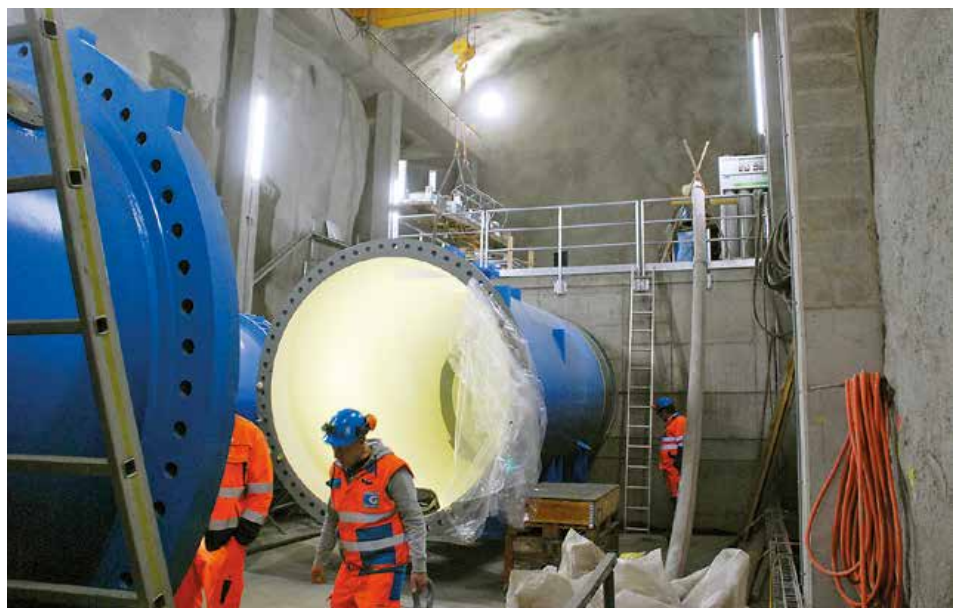
Montage Drosselklappe Handeckfluh (2)
