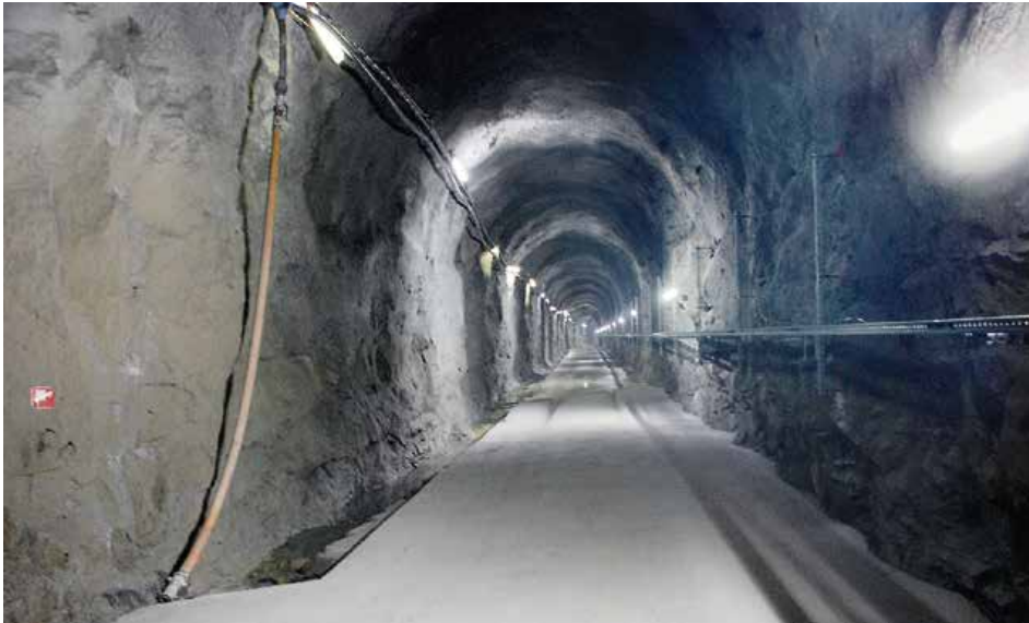
Zugangsstollen zur Apparatekamer (3)
