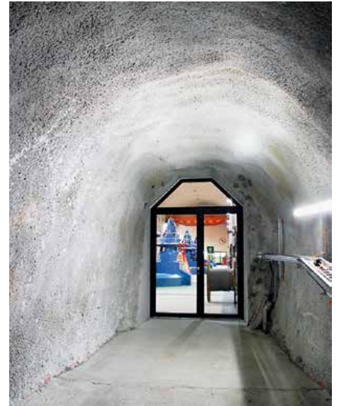
Fluchtweg zur bestehenden Kaverne
