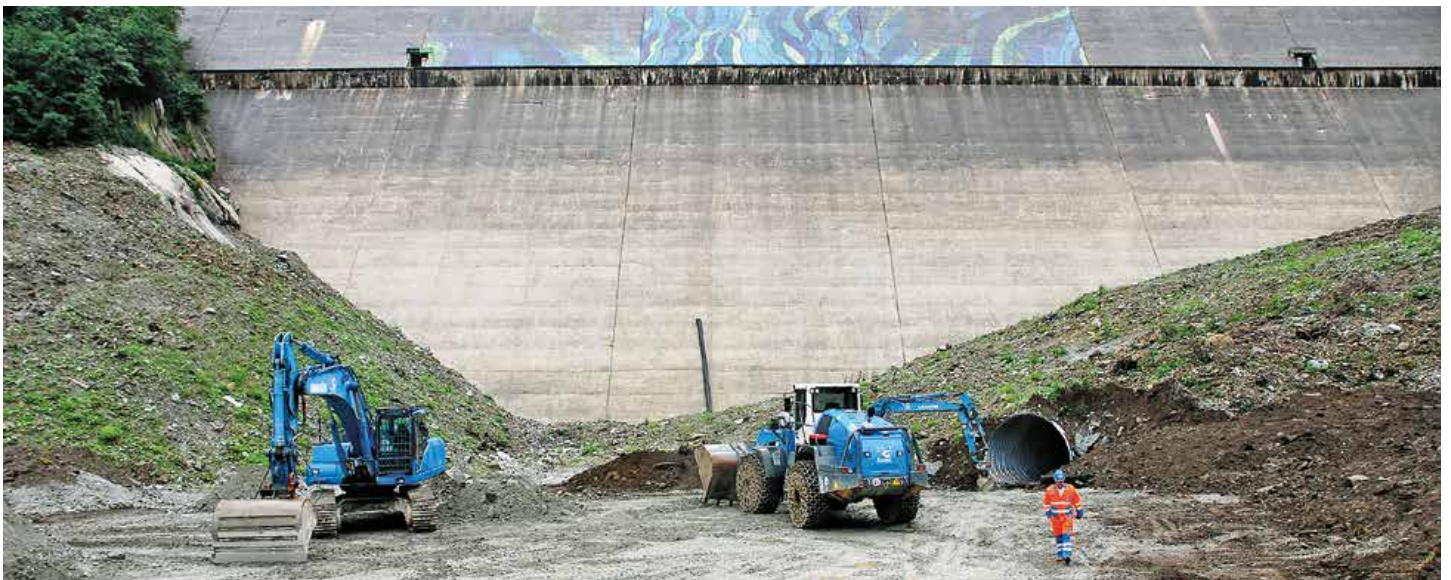
Fertigstellung Deponie Gerstenegg Mauer (4)
