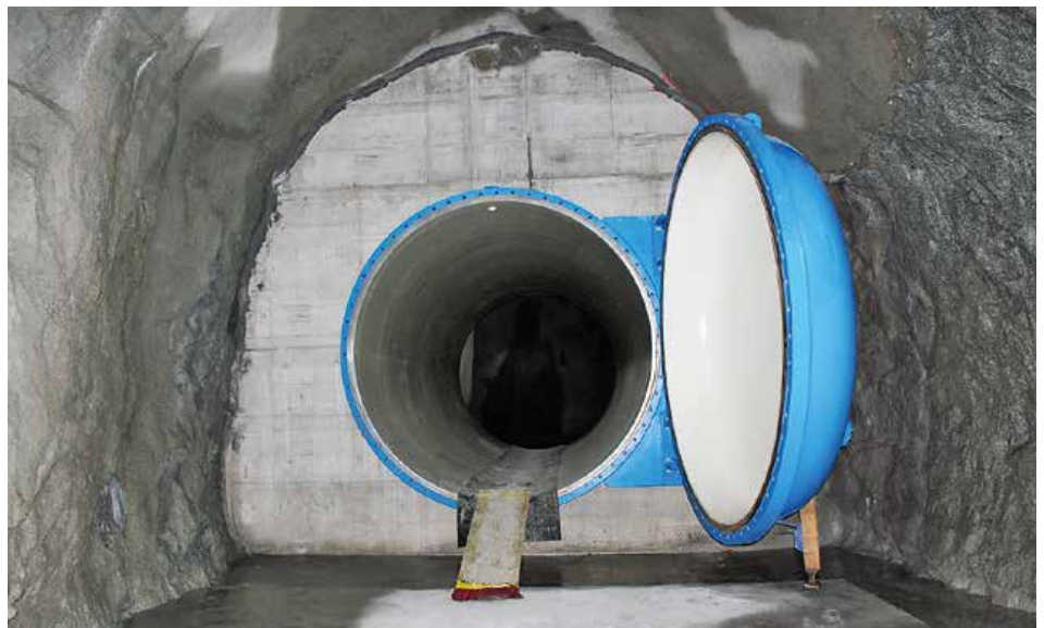
Gepanzertes Zugang zum Parallelstollen (1)
