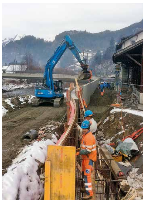
Betonwände und Staukragen mit Hofbrücke
