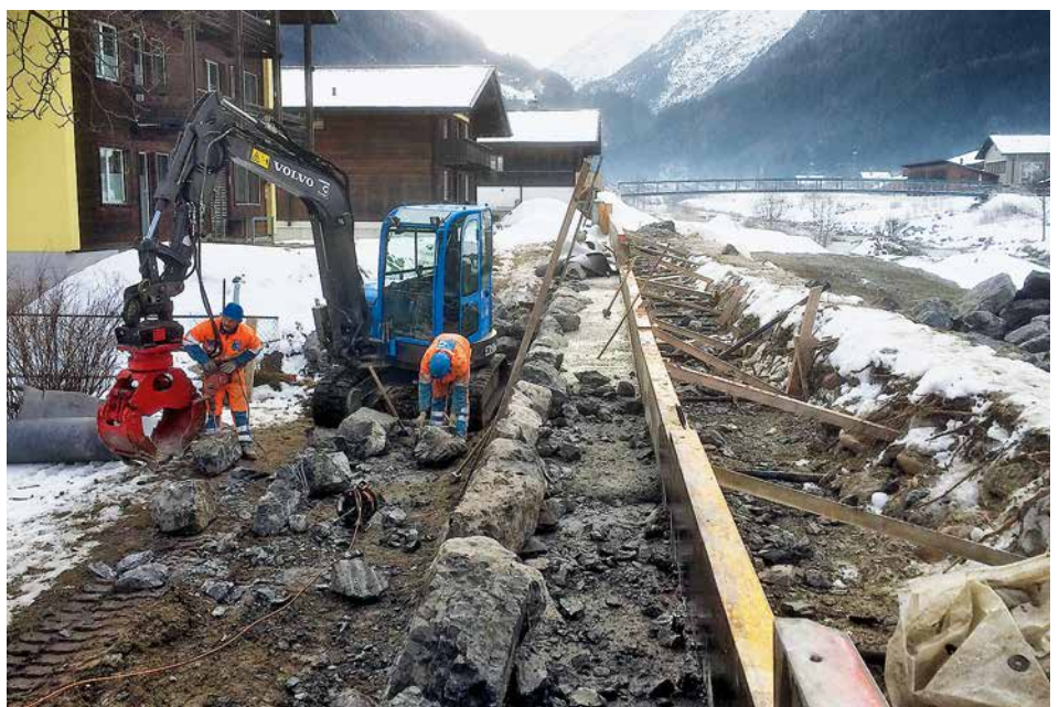
Luftseitige Bruchsteinmauer
