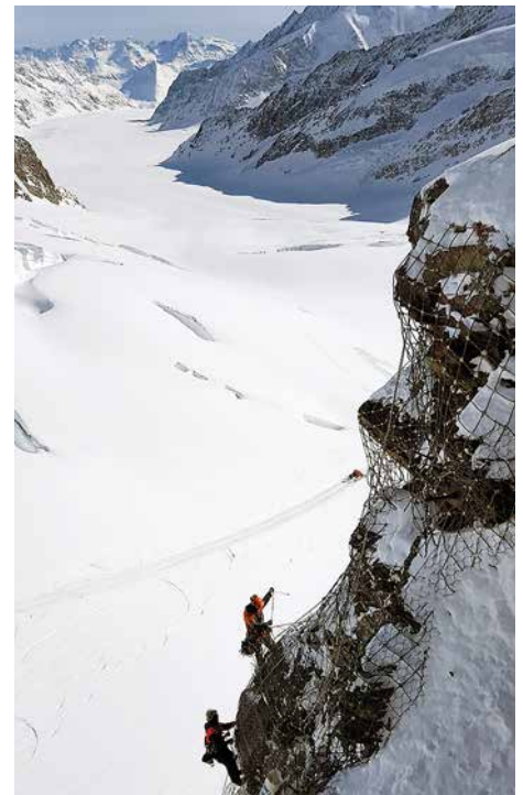
Baustelle oberhalb des Aletschgletschers
