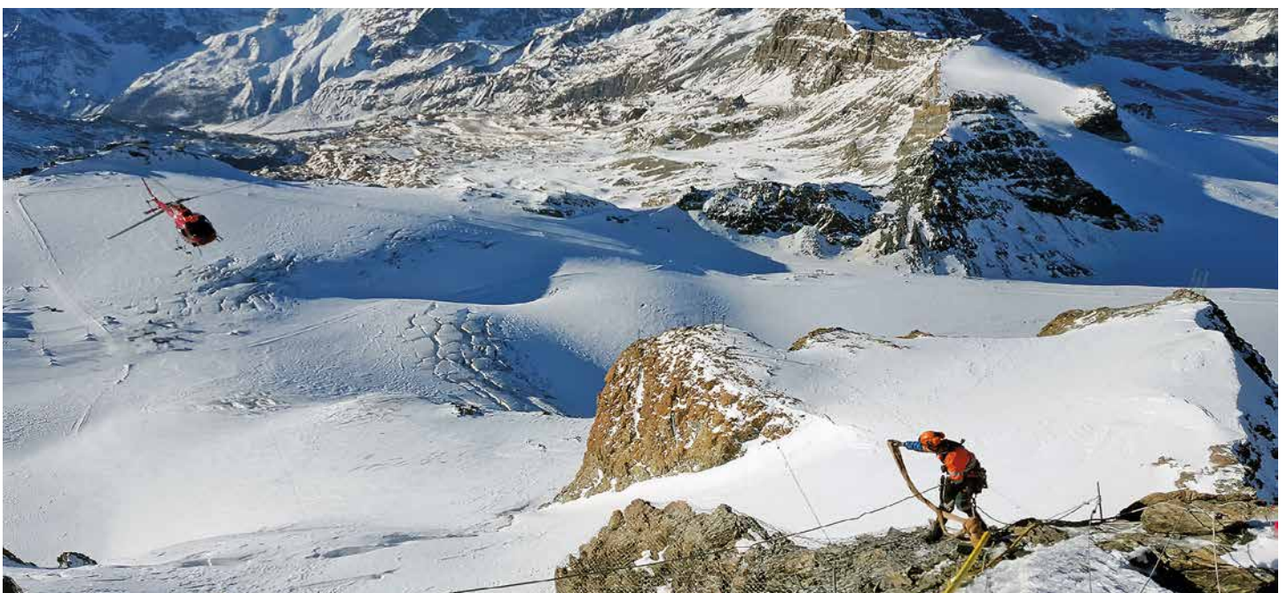
Helikopter im Anflug für die Baustelleninstallation
