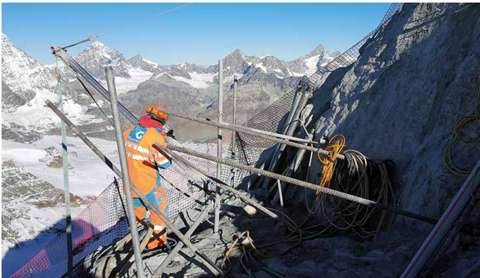
Verankerungen Foundation Transportseilbahn
