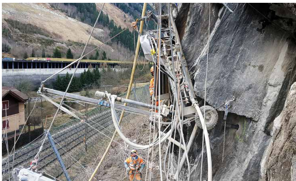
Anker bohren mit dem Moutybohrschlitten
