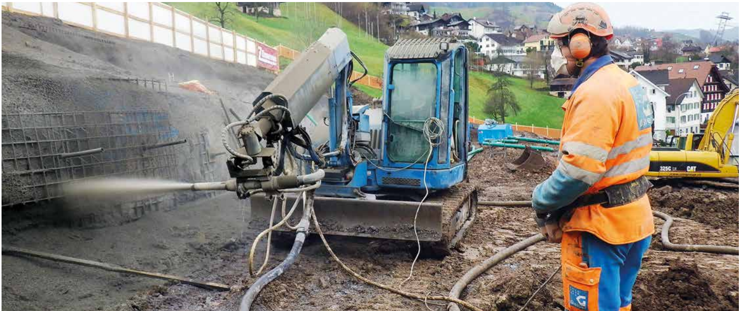
Spritzbetonarbeiten
