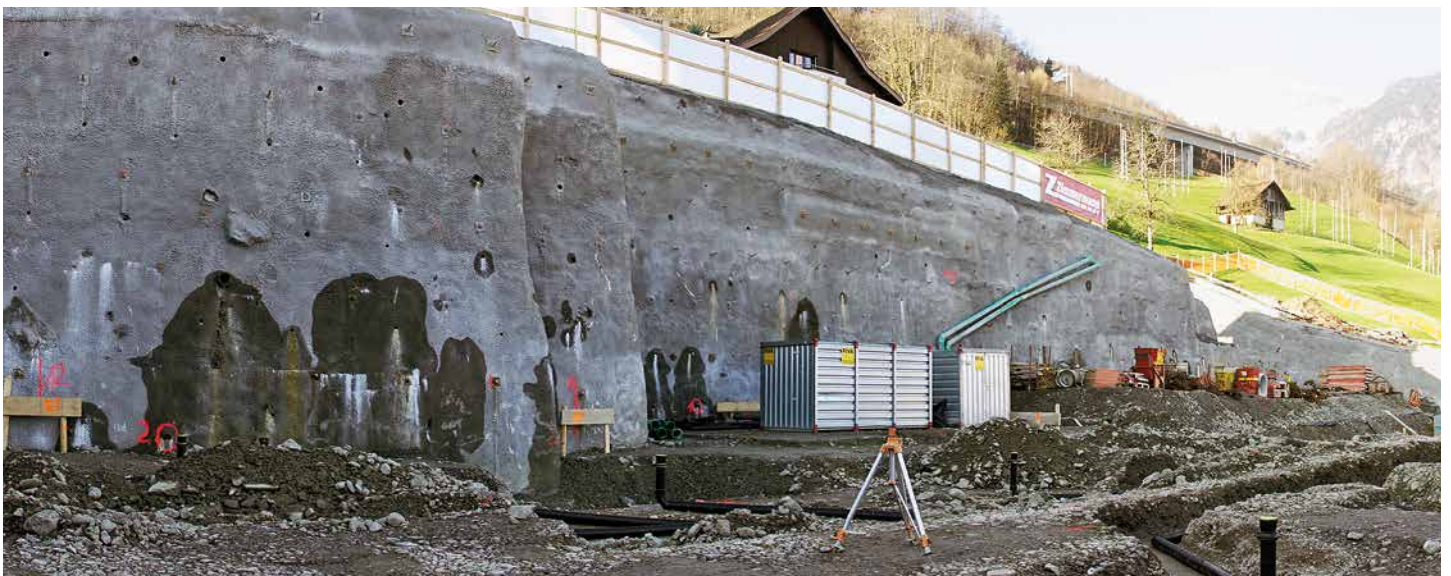
Teilansicht der fertigen Baugrube
