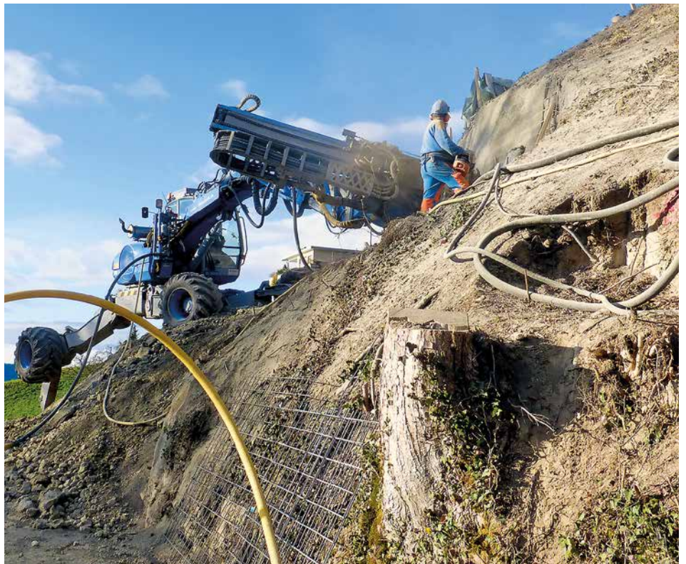
Schreitbagger Kaiser S3 im Einsatz im Gelände
