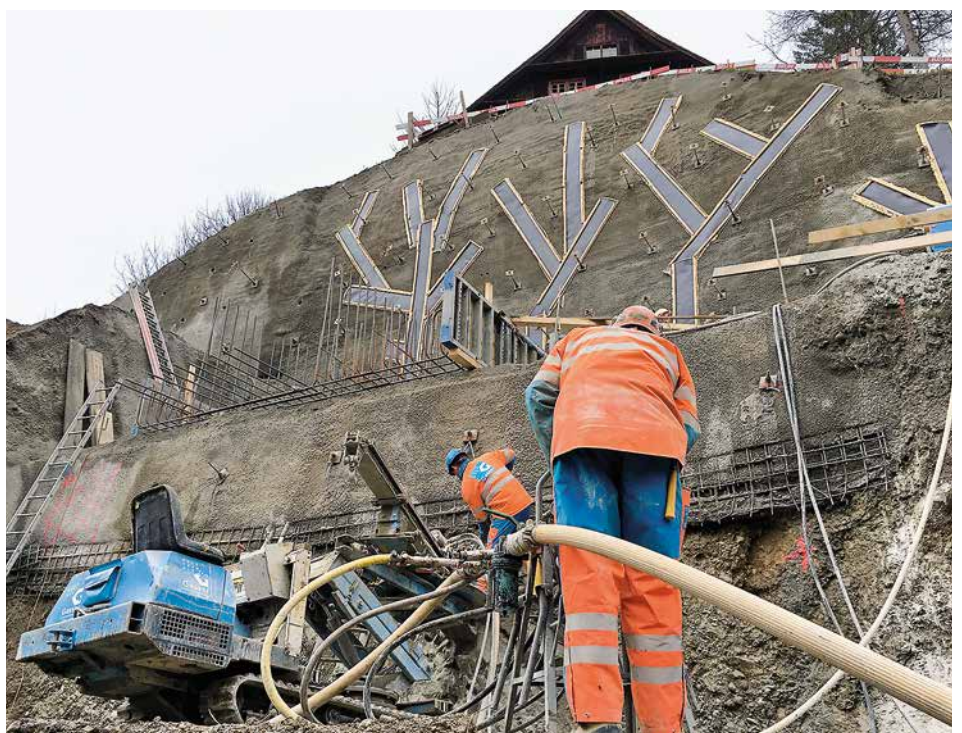
Bohrarbeiten mit Leichtbohrgerät AKU17
