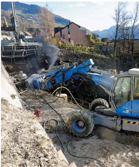
Erstellen der permanenten Sicherung
