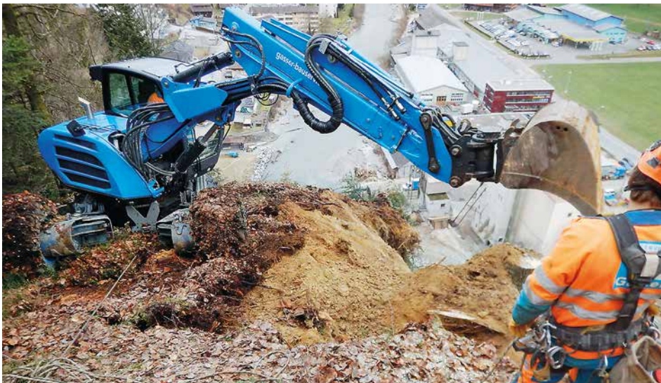
Lockermaterial abdecken mit Schreitbagger
