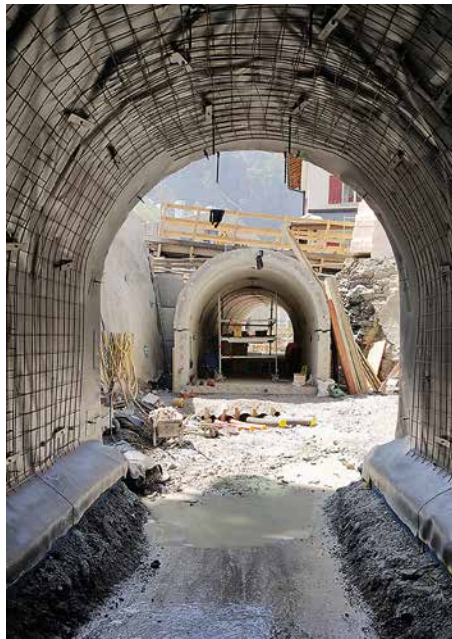
Blick vom Untertagebau Richtung Tagbautunnel
