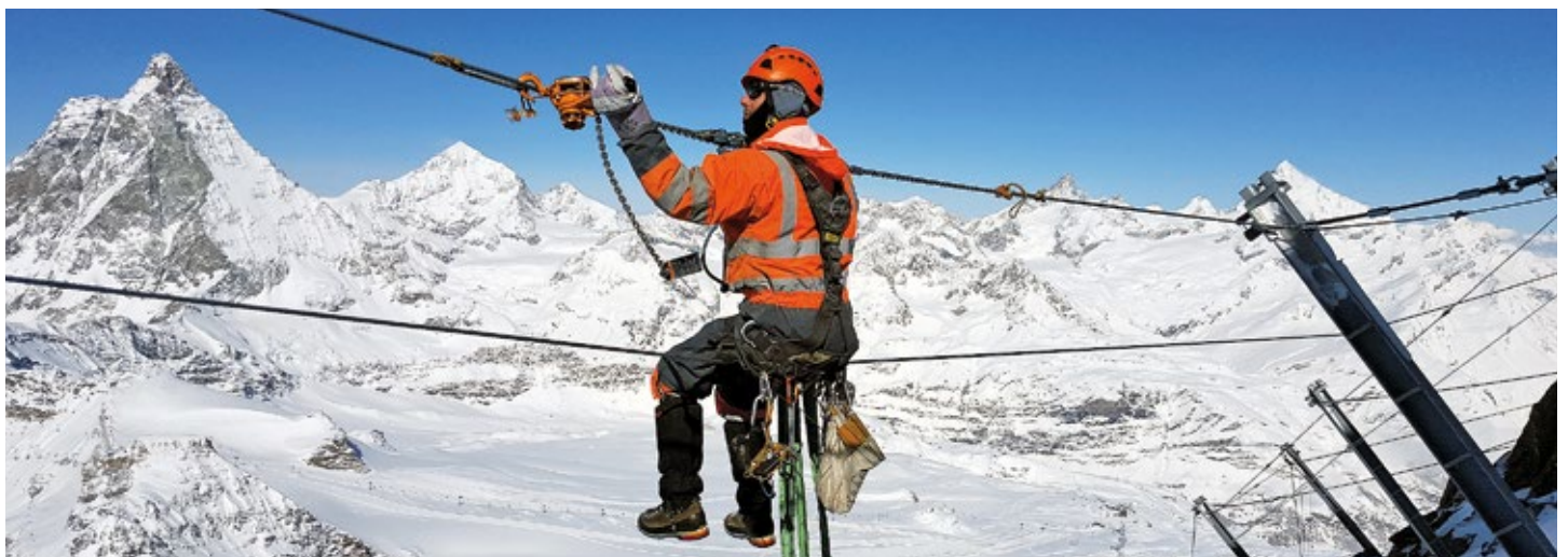
Montagearbeiten mit Blick aufs Matterhorn
