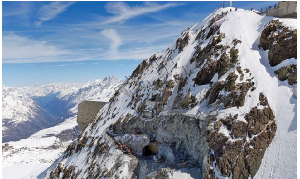
Abtragsarbeiten unterhalb der Verbauungen
