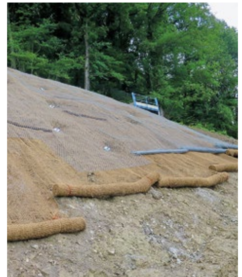
Netzabdeckung vor der Seilverspannung
