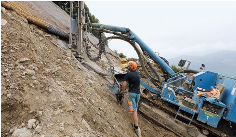
Bohrungen für Druckanker der Rückspannerfundationen
