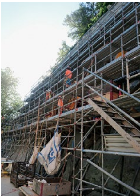
Betonarbeiten ab Gerüst
