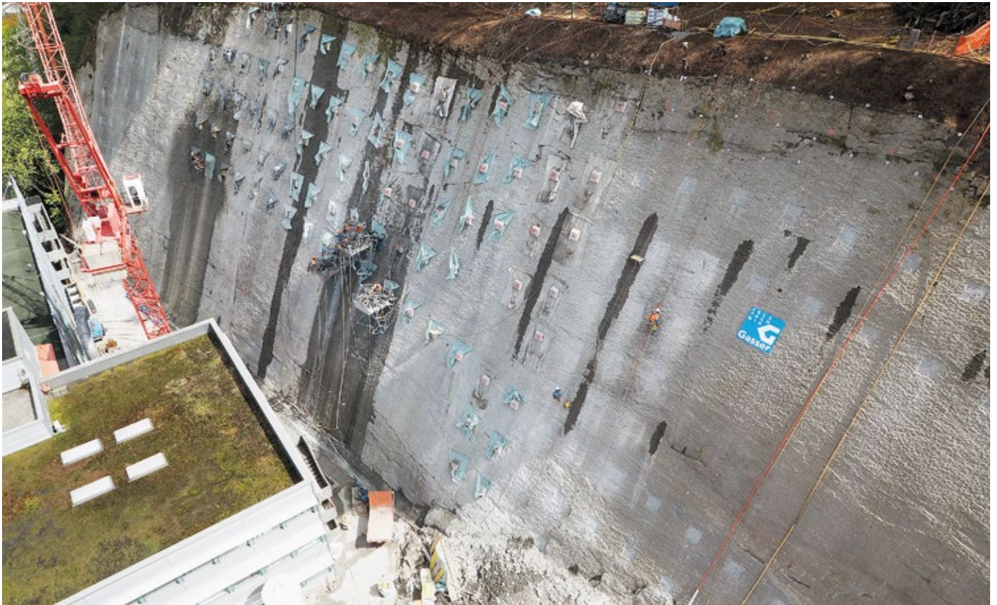
Sagenmattstrasse 7 fotografiert vom Hochhaus Sagenmattstrasse 11, Sicherung Kopfbereich mit Einzelanker
