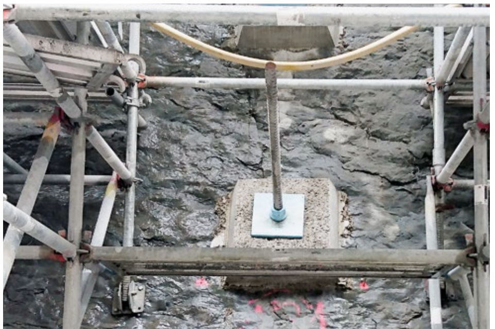
Verankerung Betonrippen
