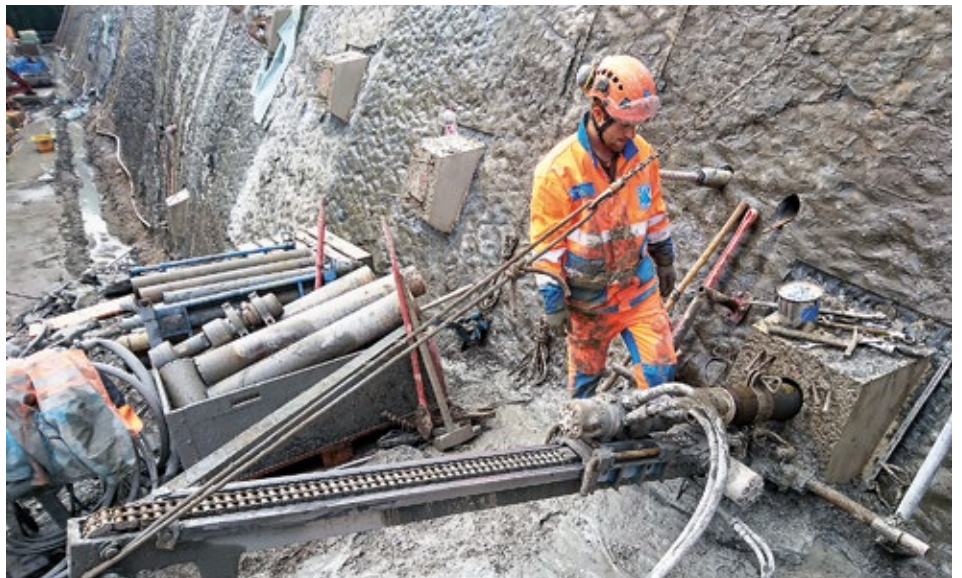
Kern- und Imlochbohrungen
