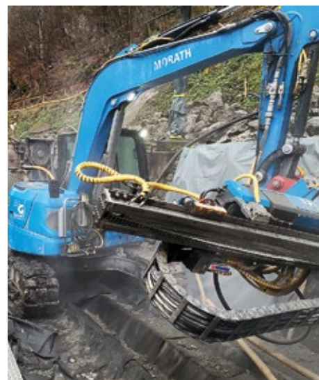
Erstellen der permanenten Anker
