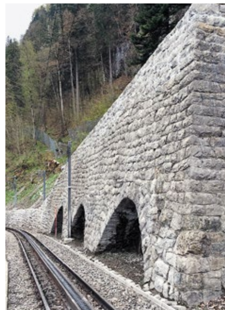
Fertig sanierte Stützbauwerke
