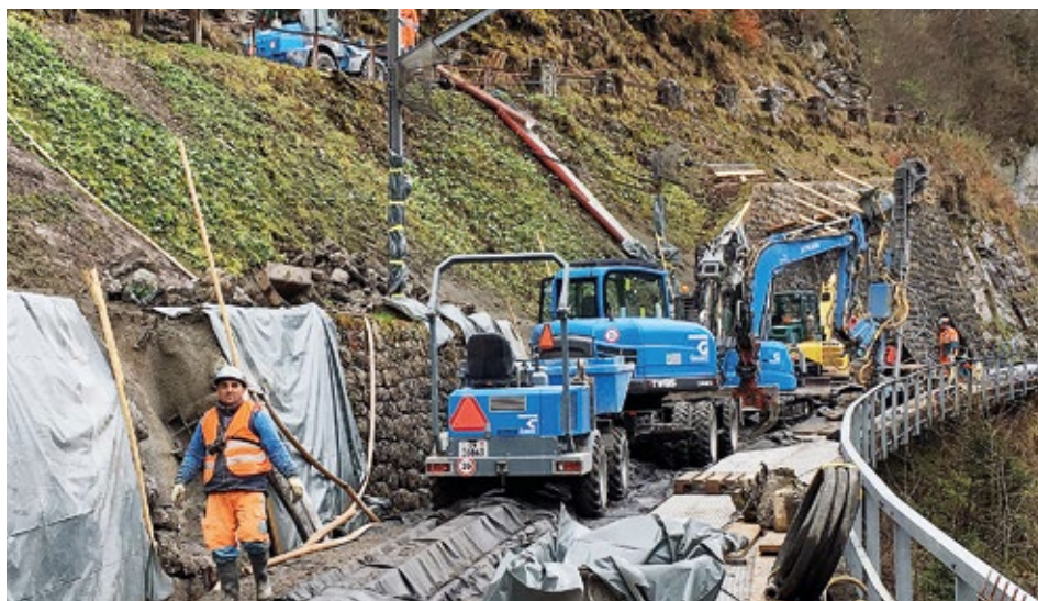
Gleichzeitige Sicherung, Bohrungen und Wiederherstellung
