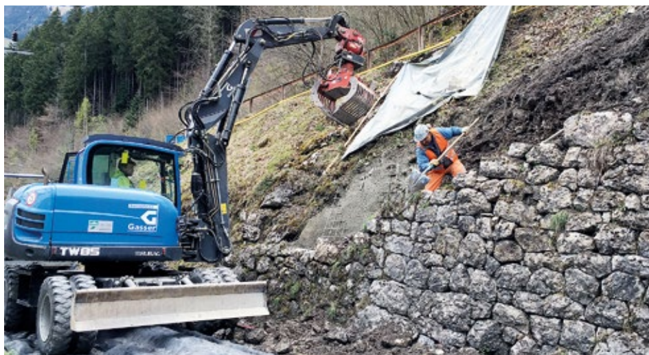
Rückbau der schadhafte Natursteinmauer
