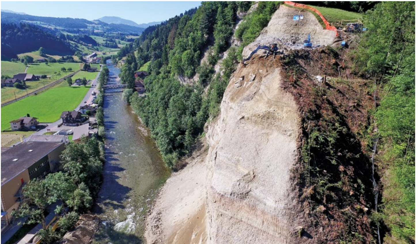
Drohnenaufnahme der Baustelle Badfluh mit Industrie- und Wohngebiet Sandmätteli und der Kleinen Emme
