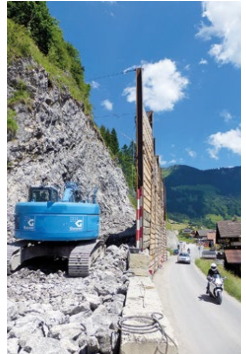
Felsabtrag mit Schutzwand
