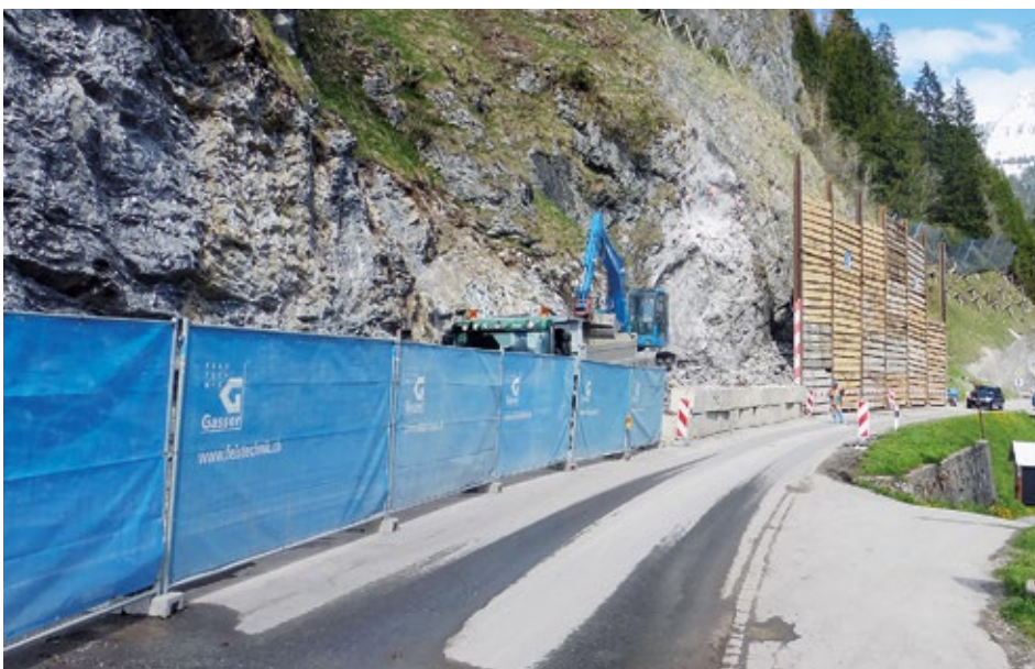
Materialabtransport unter Verkehr
