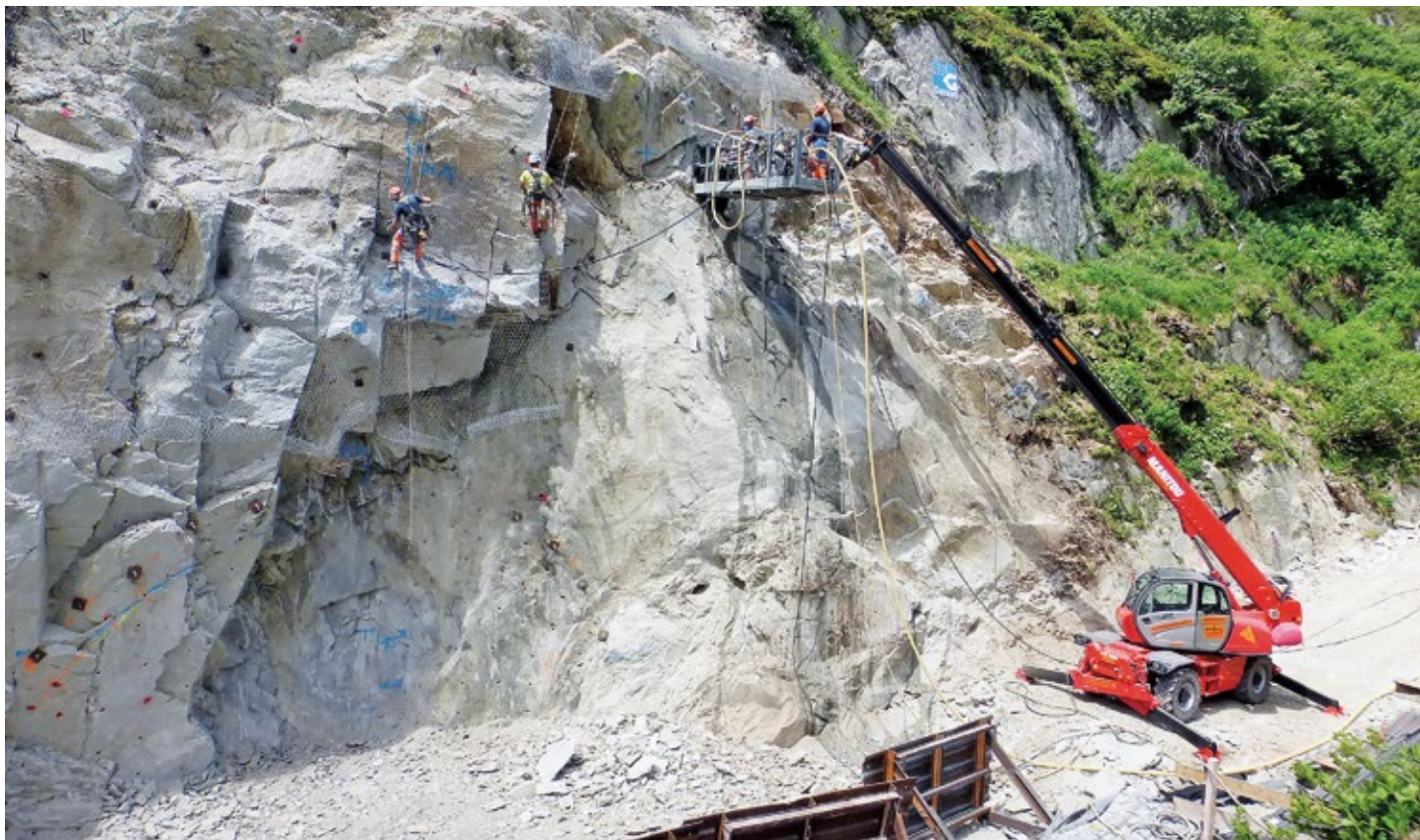
Links: Sprengtechnischer Felsabtrag von Hand gebohrt; rechts: Bohrarbeiten mit Mounity für Stabanker
