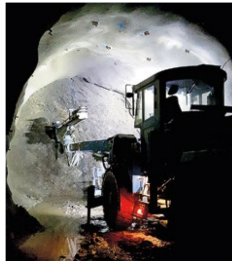
L'engin de forage E2C pendant les travaux d'avancement
