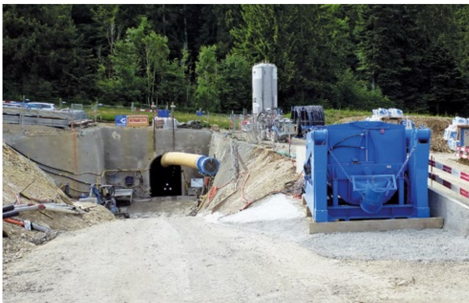
Installationsplatz am Portal Nord
