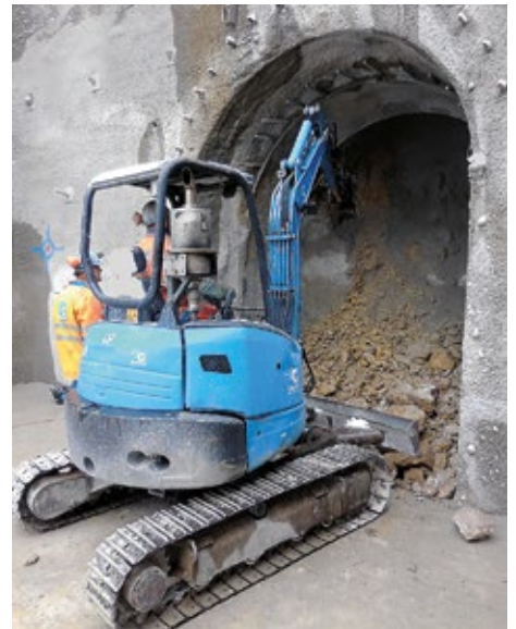
Ausbruch im Lockergestein
