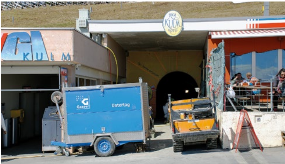
Installationsplatz Rigi Kulm
