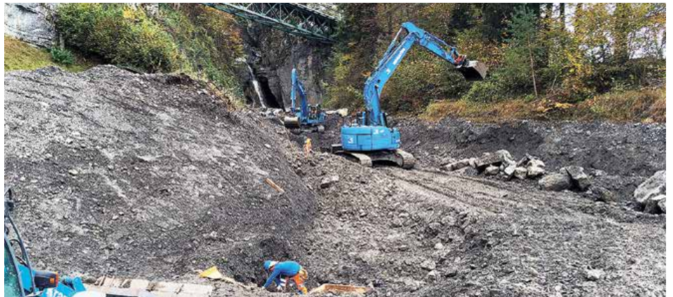
Aushub Werkleitungen Geschiebesammler
