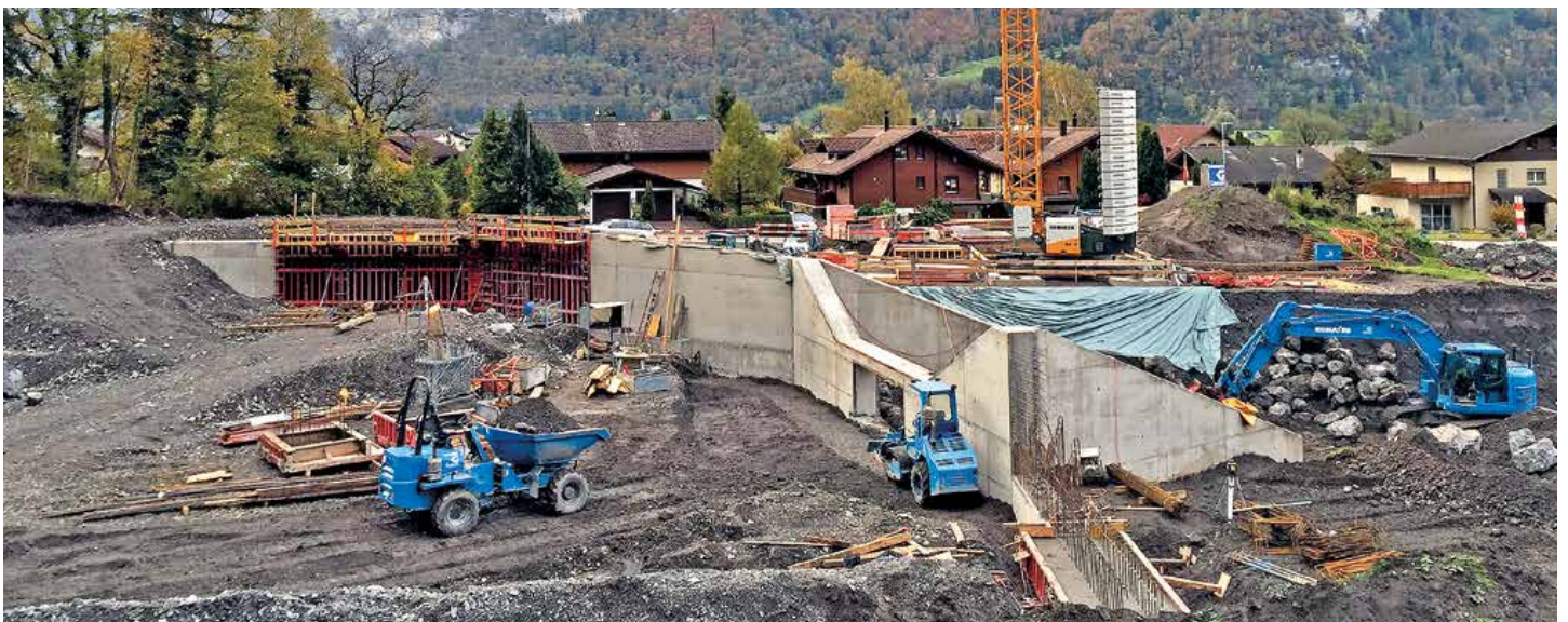
Auslaufbauwerk in Stahlbeton
