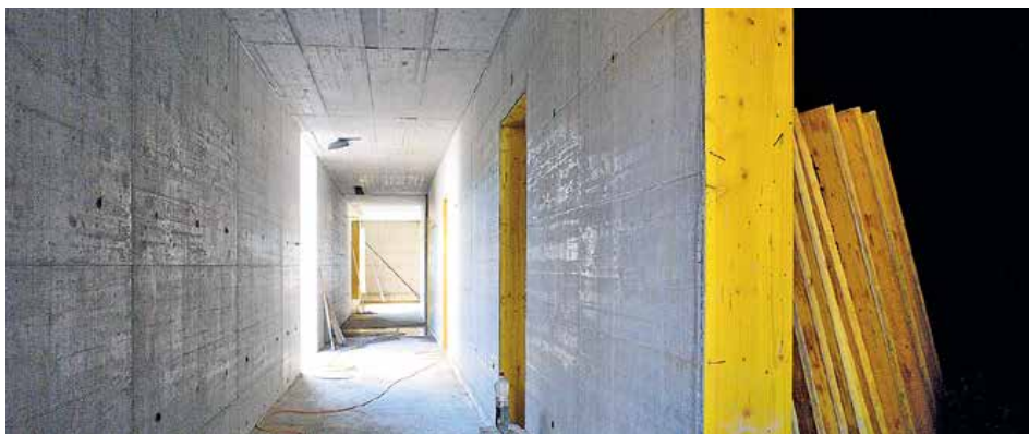
Sichtschalung im Innenbereich
