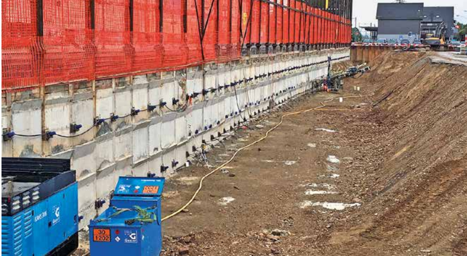
Fertige Litzenanker im Vordergrund und Bohrarbeiten im Hintergrund
