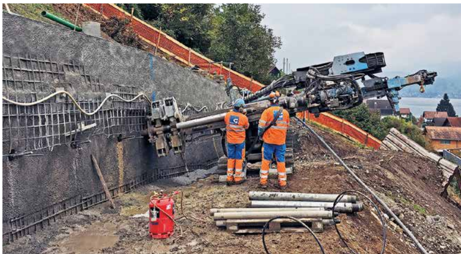
Verrohrte Bohrung \varnothing 133 mm
