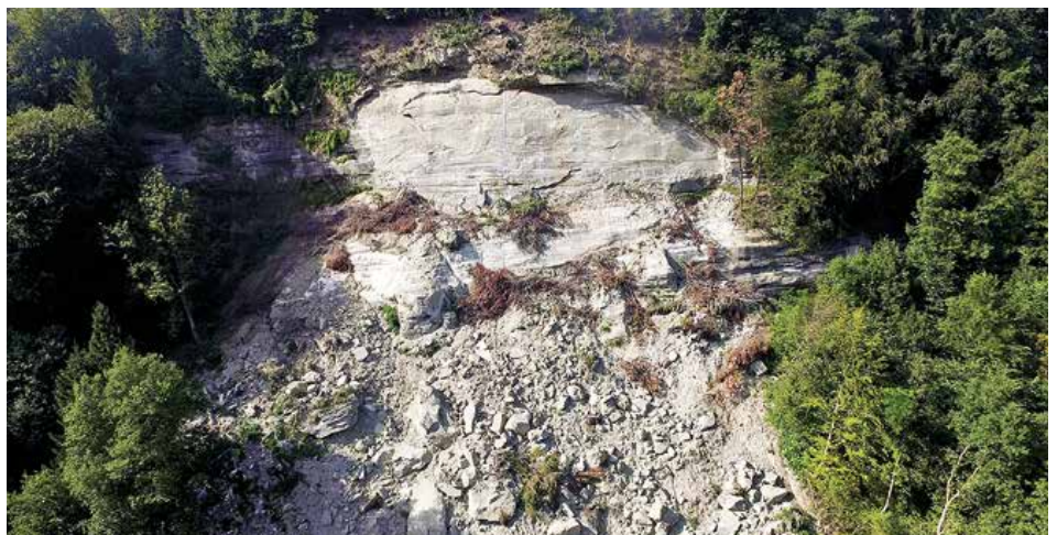
Nach dem Spontanabbruch mit Totalschaden am Wohnhaus
