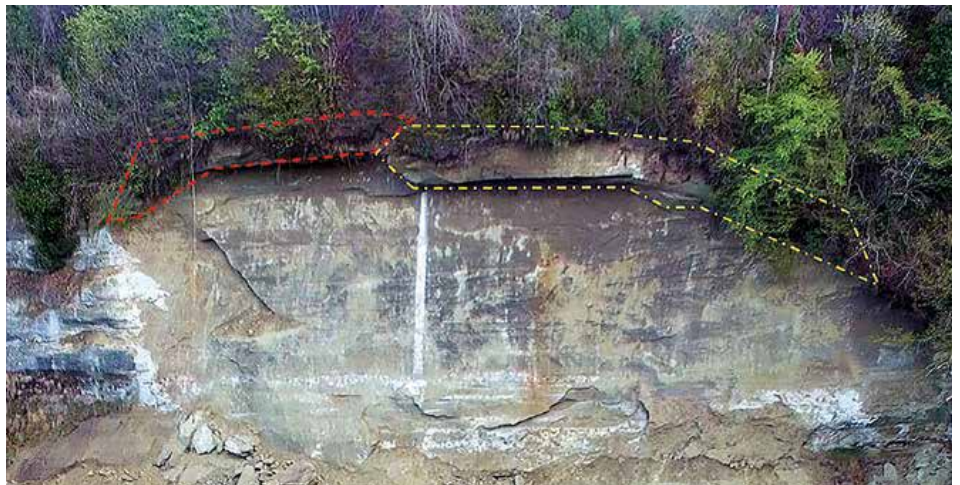
Zu entfernende Dächer oberhalb der Abrisskante
