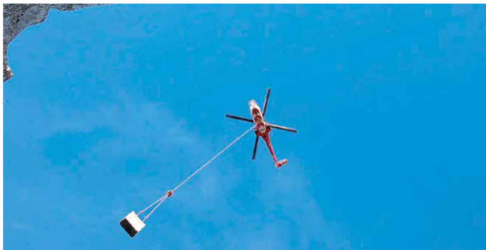
Der Helikopter fliegt Element um Element des alten Rückhaltebeckens aus
