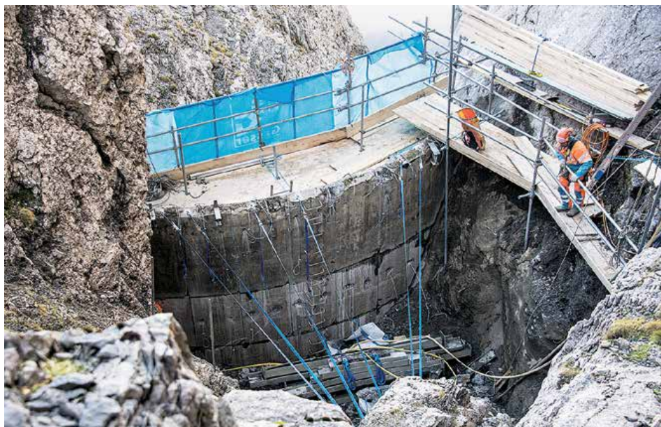
Die Elemente sind gesichert und bereit für den Abtransport mit dem Helikopter
