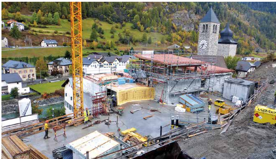
Die nicht ganz typische Sprengbaustelle
