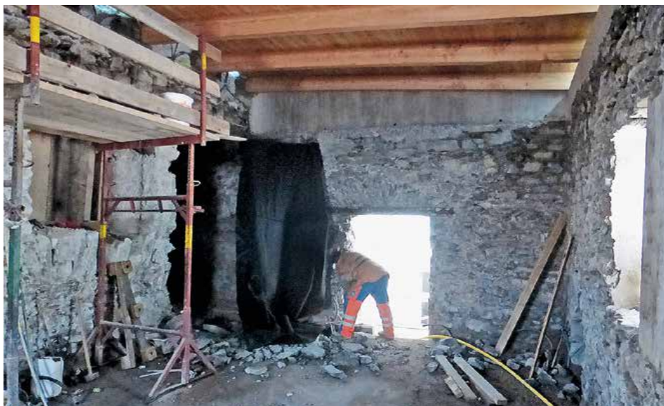
Sprengarbeiten im Gebäude mit neuem Dach
