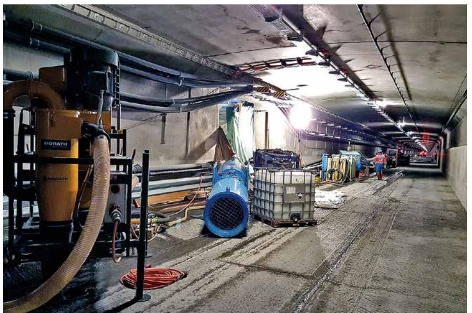
Baustelleninstallation im Zugangsstollen
