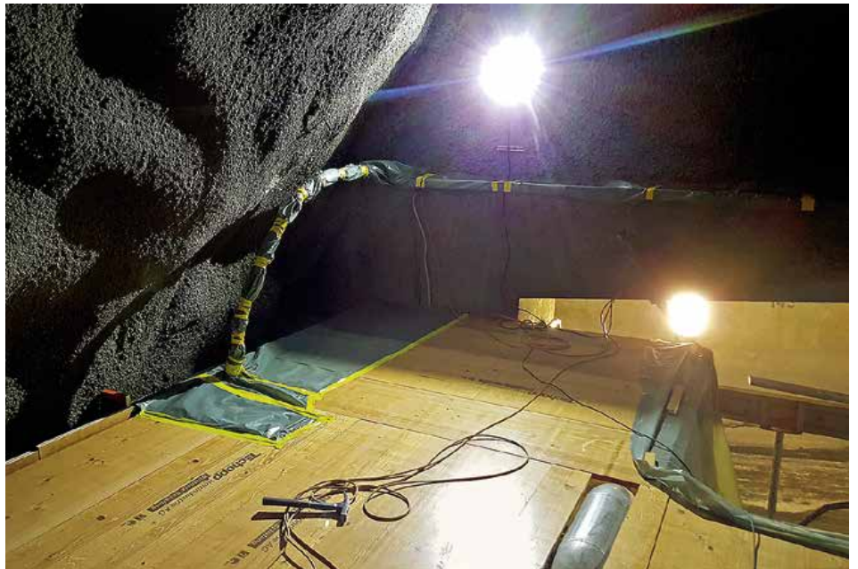
Arbeitsgerüst über dem Wasserreservoir
