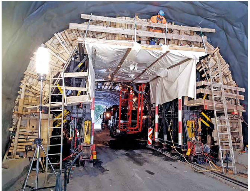
Der Schalungswagen mit Stirnschalung
