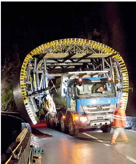
Der Transport des Schalungswagens erfordert Massarbeit
