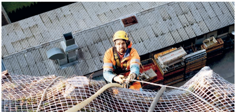
Abseilen zur Arbeitsstelle
