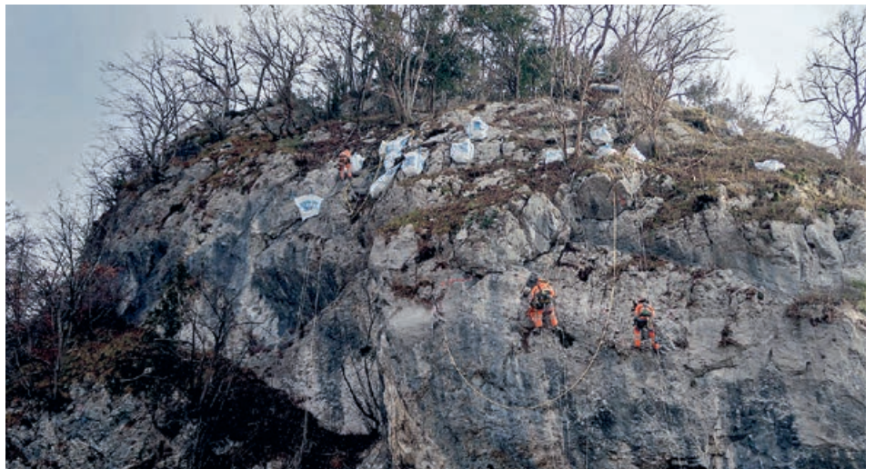
Felsrückbau der Einzelstellen
