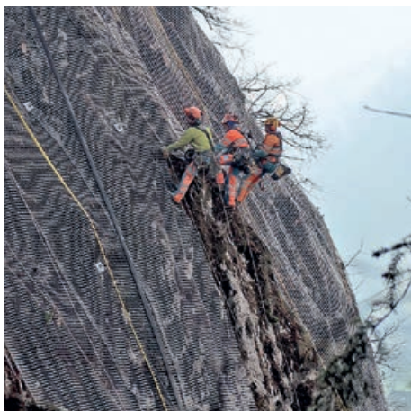
Montage der Kunststoff-Netzabdeckung
