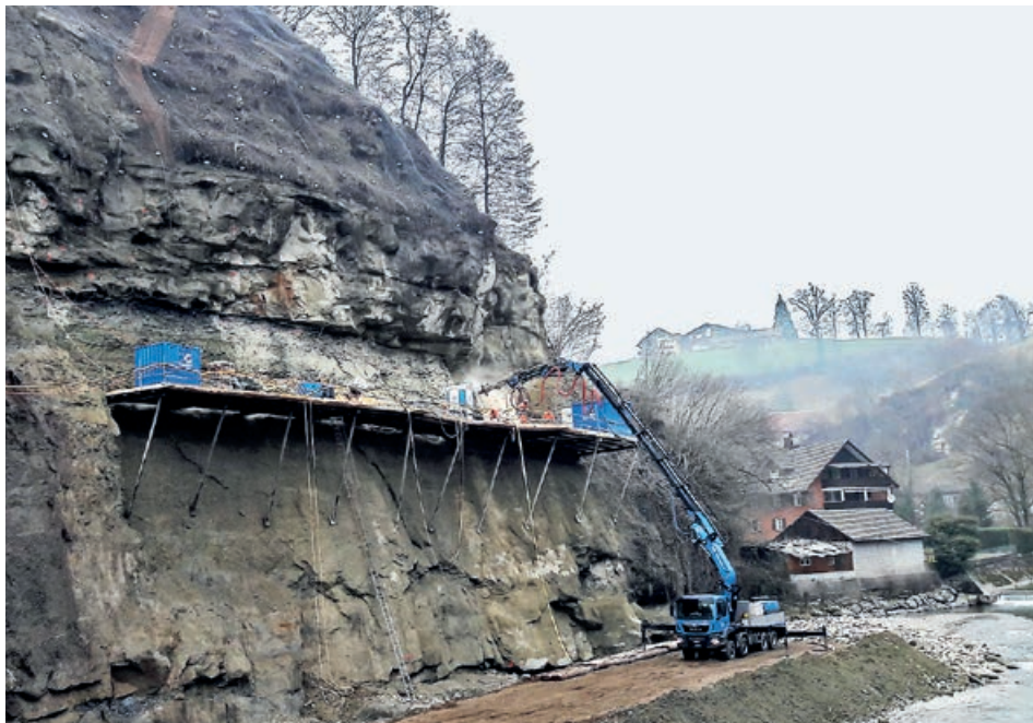
Bohrarbeiten in der Kleinen Emme mit unserem Bohr-LKW
