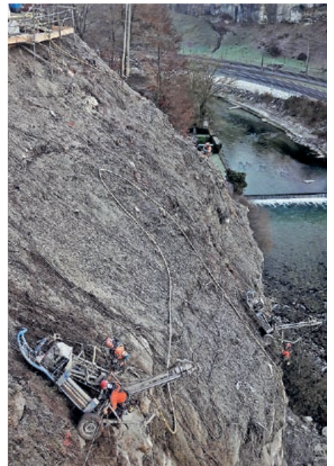
Bohrequisen gleichzeitig im Einsatz
