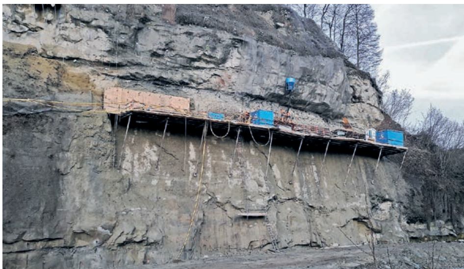
Die grosse Betonscheibe hat eine eigene Installation auf unserer Spezialplattform
