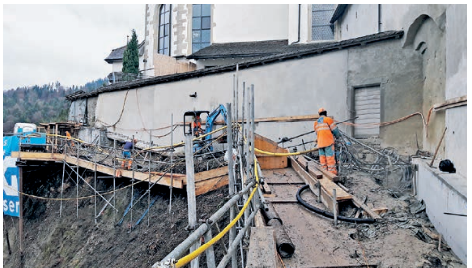
Aushub-, Bohr- und Betonarbeiten auf engem Raum (Mauerfussicherung)
