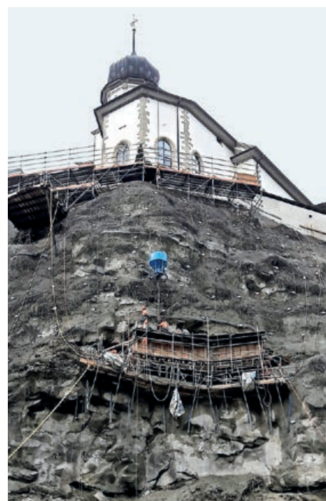
Betonieren der Scheibe 3 mitten in der Felswand
