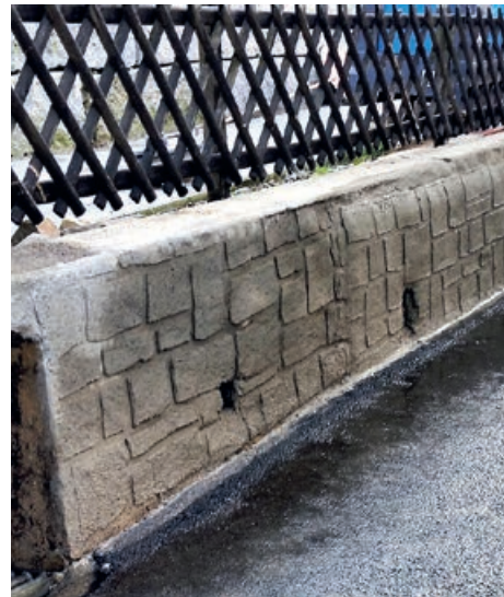
Nachher: Spritzbeton mit Natursteinoptik
