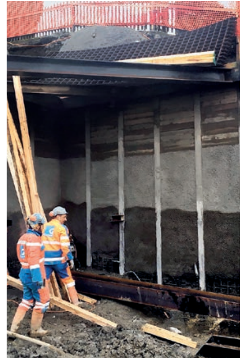
Fertiggestellte Ausfachung der Rühlwand, Montage der Aussteifung
